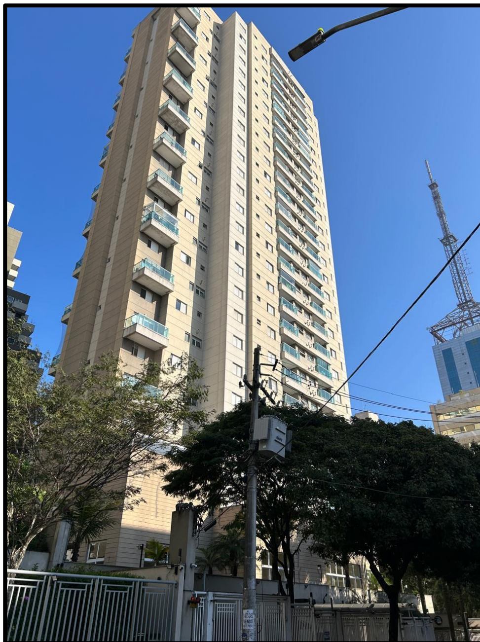
Foto nº 02 – Vista da fachada frontal do edifício, a partir da Rua Apeninos.
