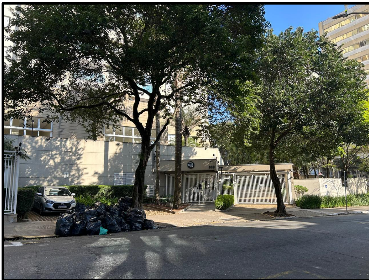
Foto nº 05 – Vista dos portões que dão acesso às pessoas e veículos.
