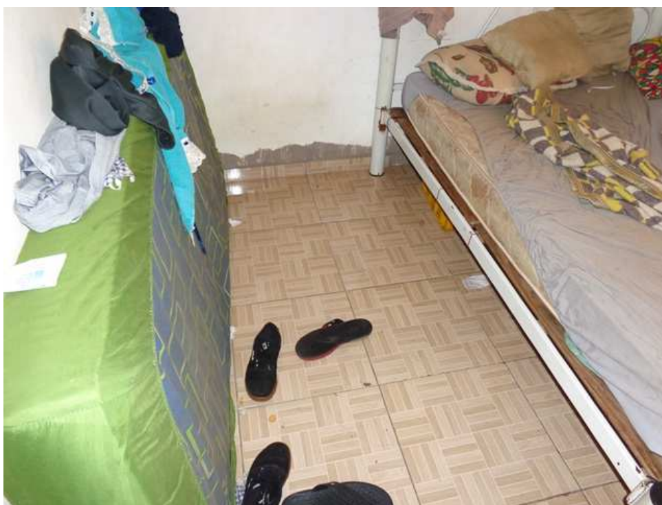
Foto 3 – detalhe do piso cerâmico no dormitório 1
