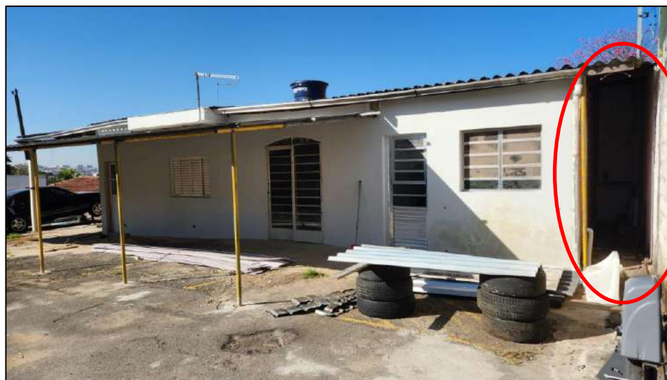
Foto 05 – Vista do lado direito (detalhe para o recuo de aproximadamente 1m do muro frontal)
