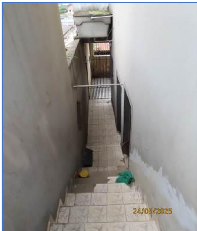
Foto nº 19: Acesso ao subsolo da casa.
