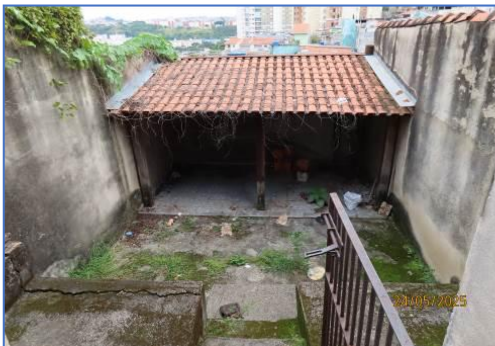
Foto nº 23: Vista geral da edícula, localizada no subsolo e nos fundos do terreno
