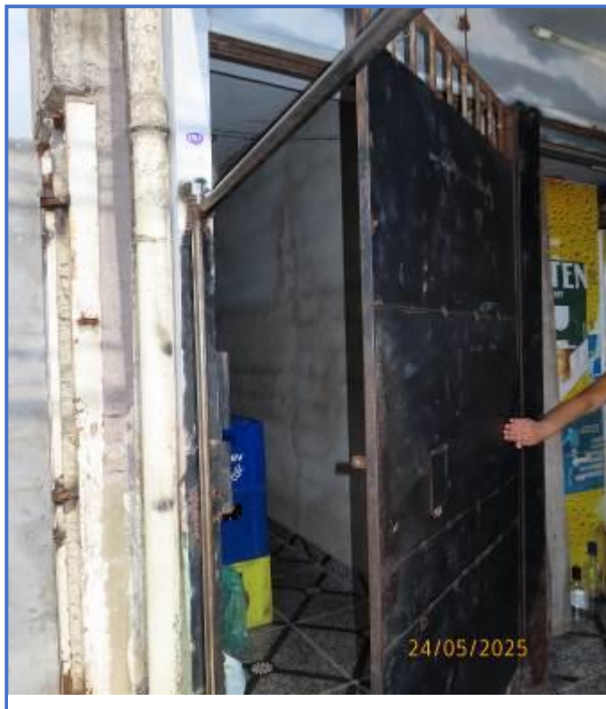
Foto nº 25: Acesso as casas do fundo do terreno
