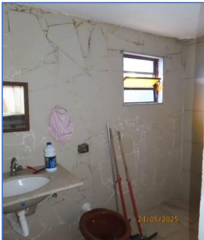
Foto nº 08: Vista parcial do banheiro da casa 1.
