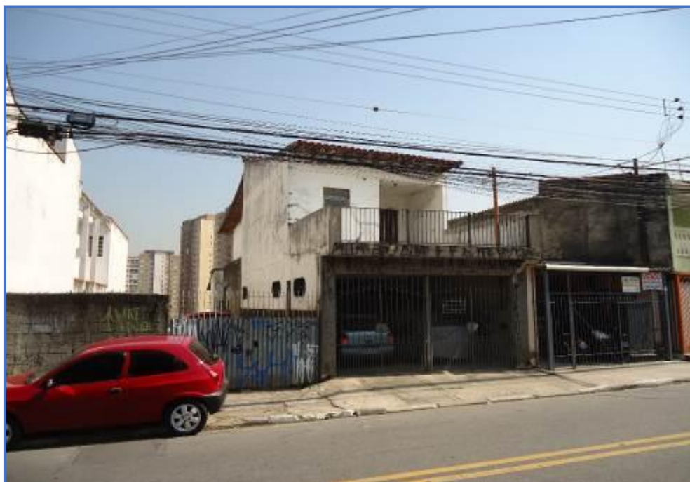
Foto nº 02: Outra vista da Av. Antônio Perez Paniagua, com detalhe para o imóvel objeto da avaliação.
