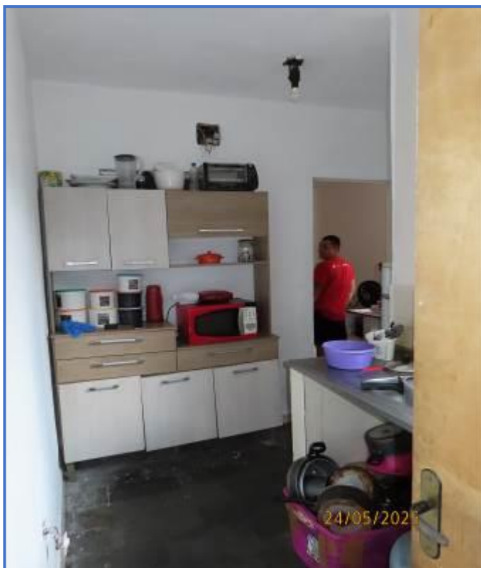
Foto nº 32: Vista parcial de outra cozinha da construção dos fundos casa 4.
