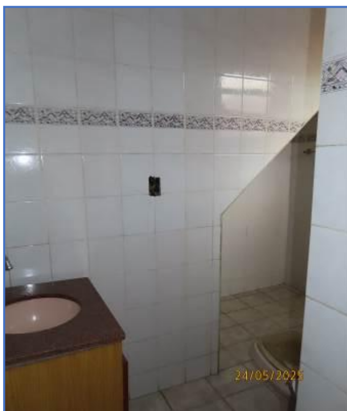
Foto nº 14: Vista geral do banheiro da casa 2.
