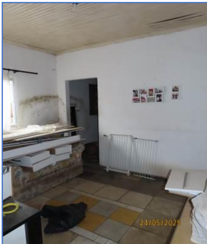
Foto nº 07: Vista parcial da sala de estar da casa 1.
