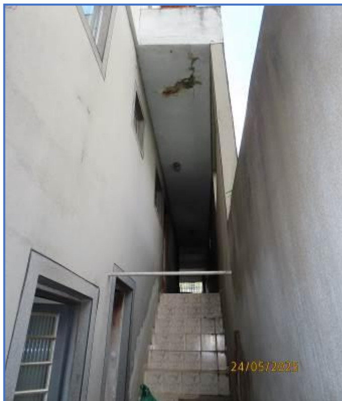
Foto nº 24: Outra vista geral do corredor de acesso lateral da residência.
