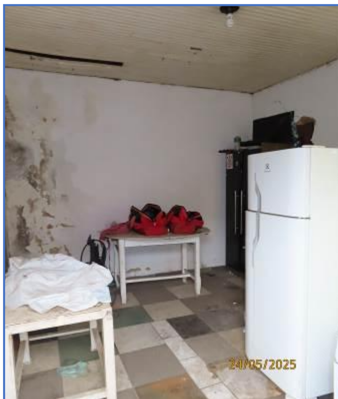
Foto nº 06: Vista geral da cozinha da casa 1.
