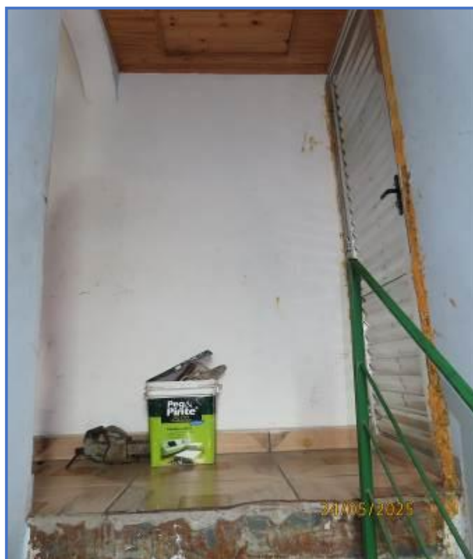
Foto nº 12: Vista geral do acesso a casa 2.
