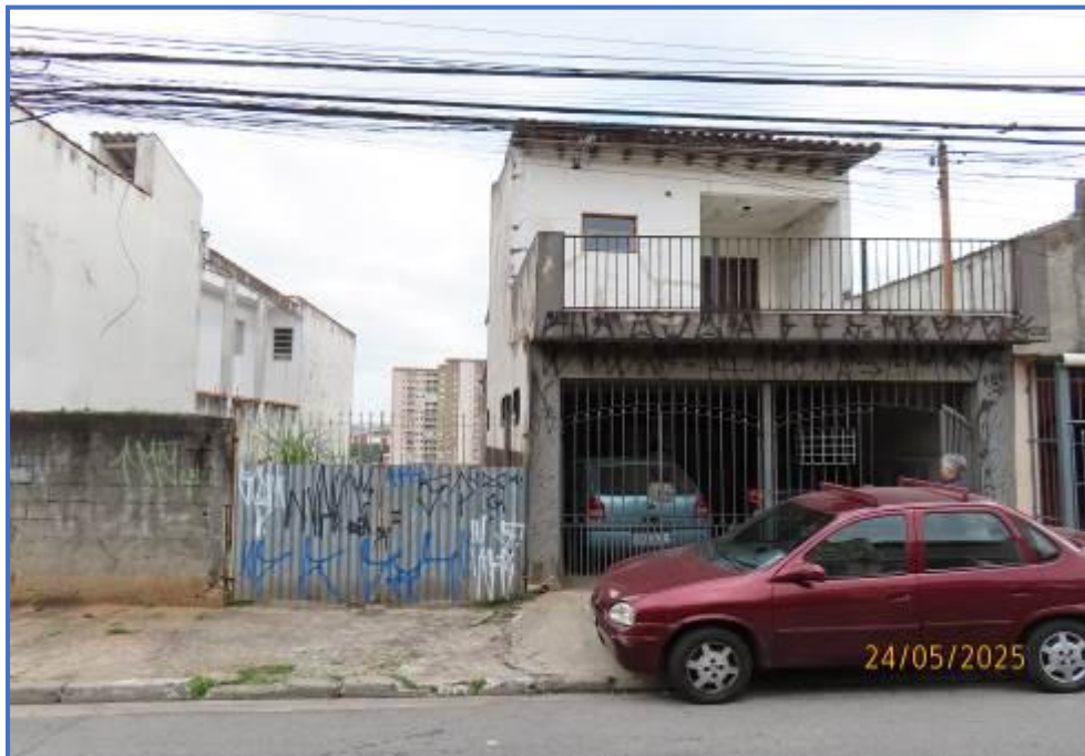
Foto nº 03: Vista da fachada do imóvel objeto.
