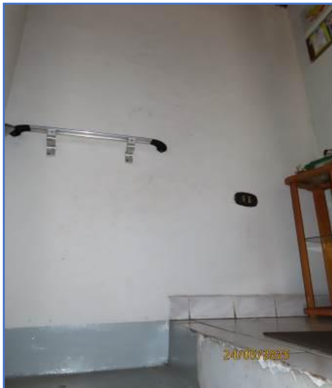
Foto nº 17: Outra vista do acesso ao 3 pavimento.
