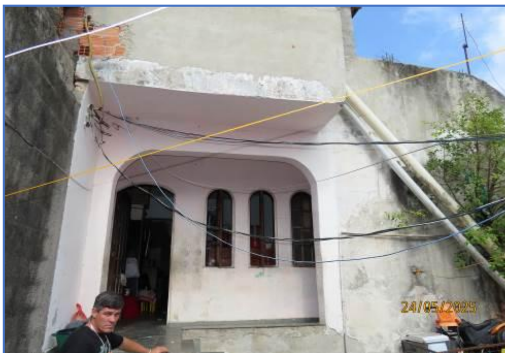
Foto nº 29: Vista geral da fachada da construção dos fundos.
