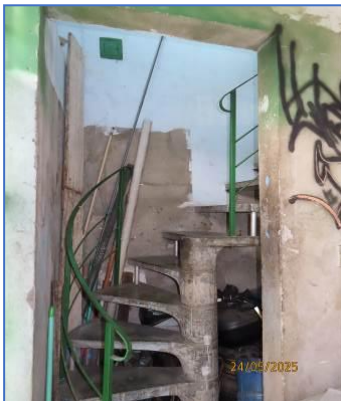
Foto nº 11: Acesso na garagem a casa 2 1º pavimento e 2º pavimento
