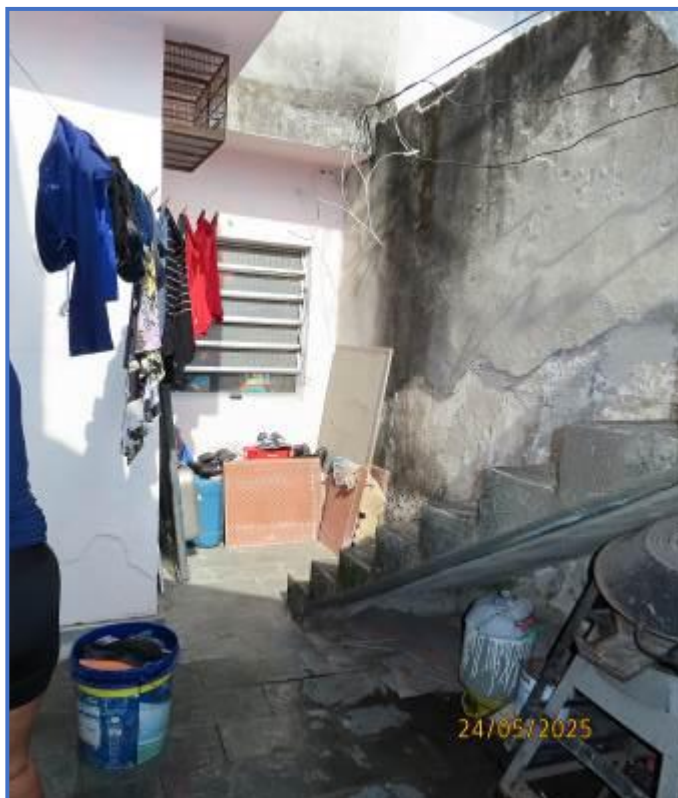
Foto nº 34: Vista geral da lavanderia e acesso a casa no pavimento superior da construção dos fundos.
