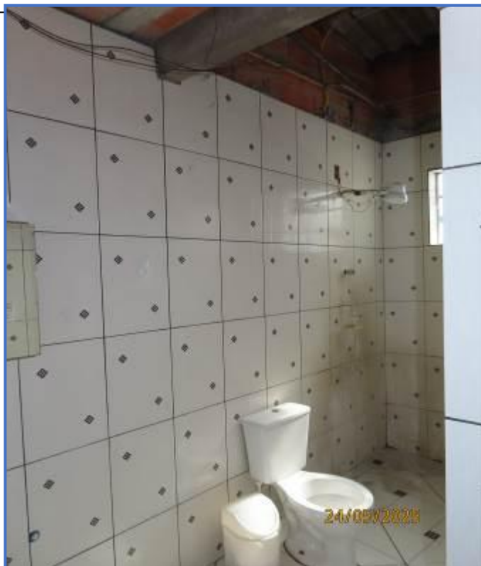
Foto nº 39: Vista parcial do banheiro da casa 5
