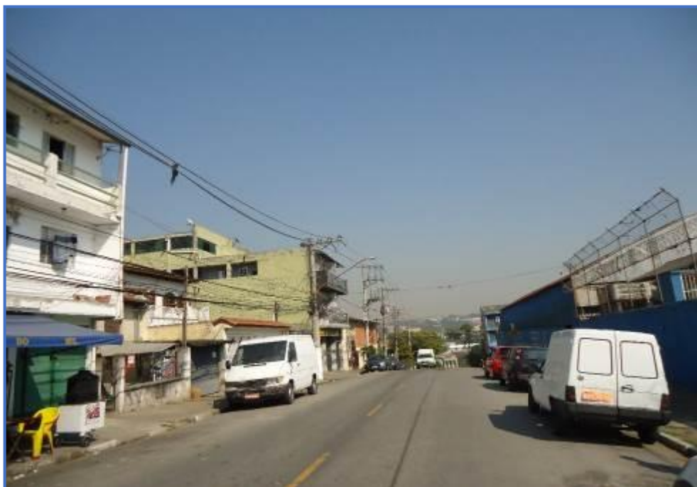
Foto nº 01: Vista geral da Rua Madre Joana Zonca na altura do imóvel objeto da avaliação.
