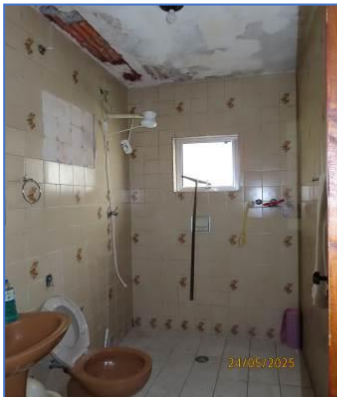
Foto nº 10: Vista parcial do banheiro.
