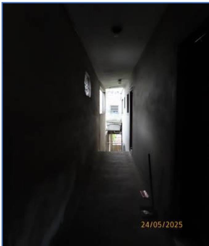
Foto nº 05: Acesso pelo corredor lateral.
