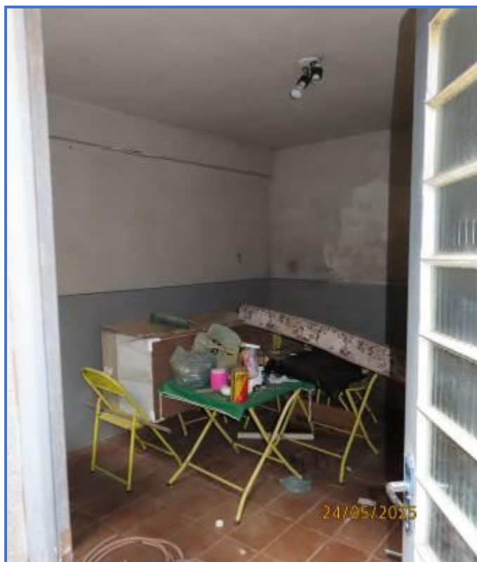
Foto nº 20: Vista parcial do 1º depósito.
