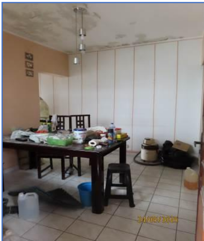
Foto nº 06: Vista geral da sala de jantar.
