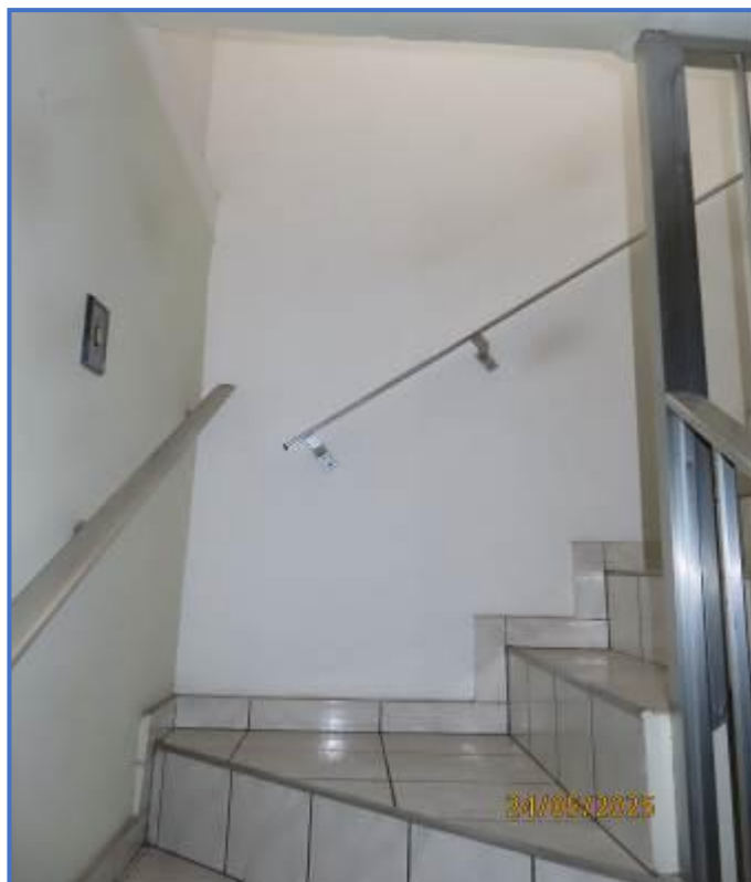
Foto nº 12: Vista parcial do acesso ao pavimento superior.
