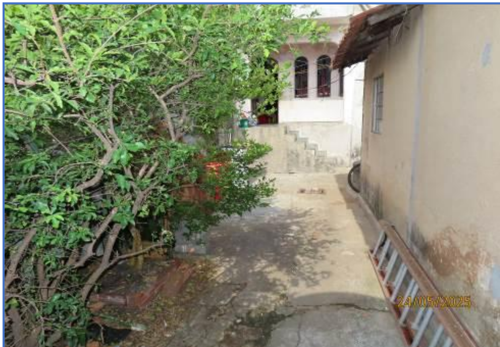
Foto nº 27: Vista do pátio principal de acesso as casas do fundo do terreno. Nota-se a direita parede da casa 1.
