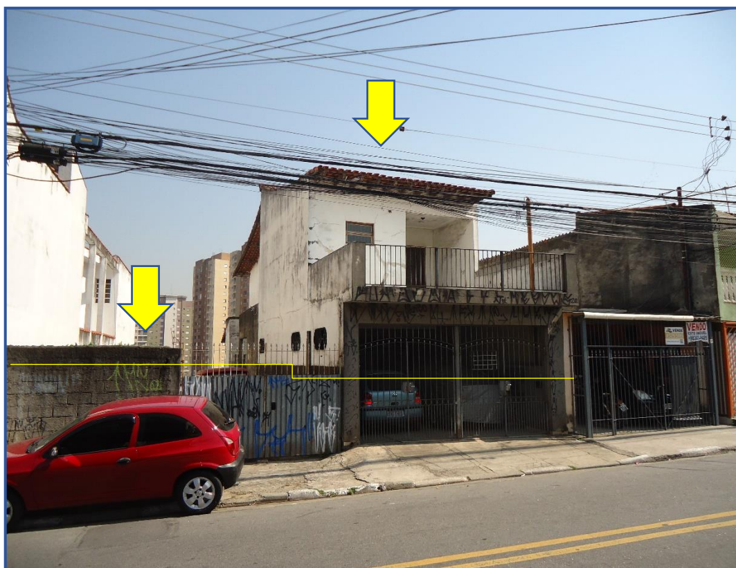
Foto nº 1: Vista geral da fachada do imóvel avaliando, com detalhe para a o terreno lateral e sobrado residencial.
