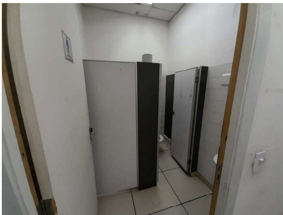
Vista de um dos banheiros.
