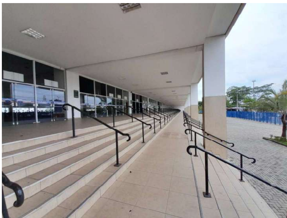
Vista da entrada principal (rampa com degraus).
