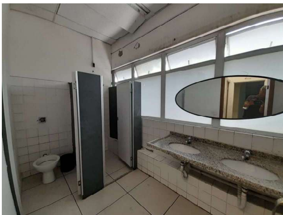
Vista de um dos banheiros.
