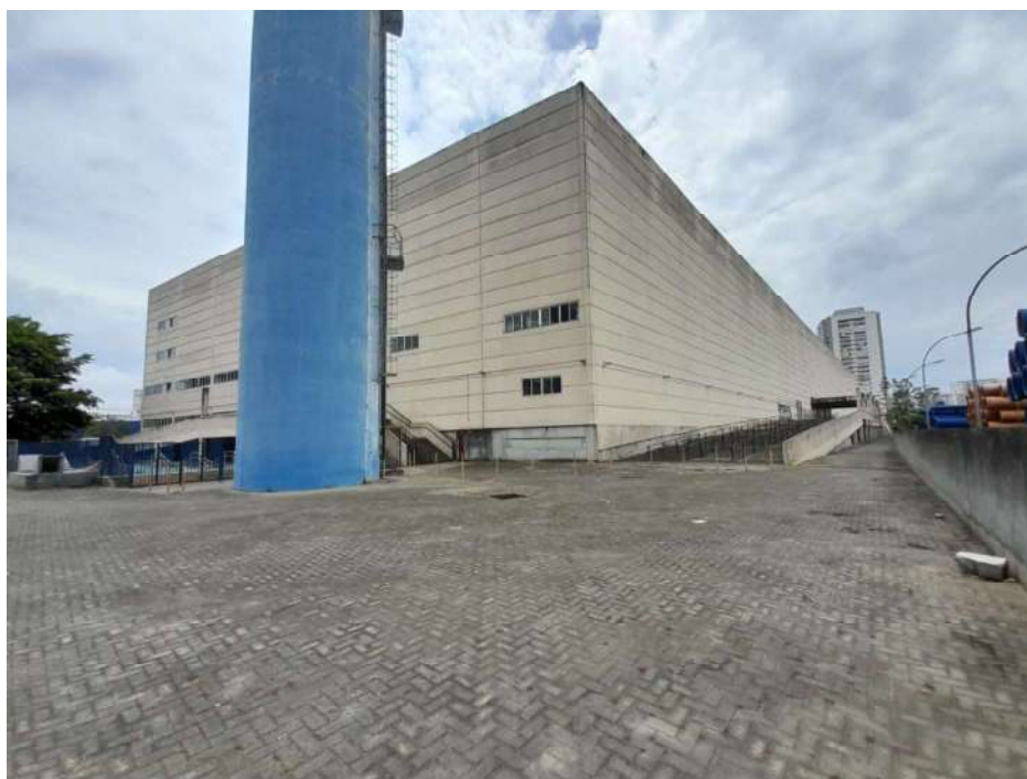
Vista externa do imóvel.
