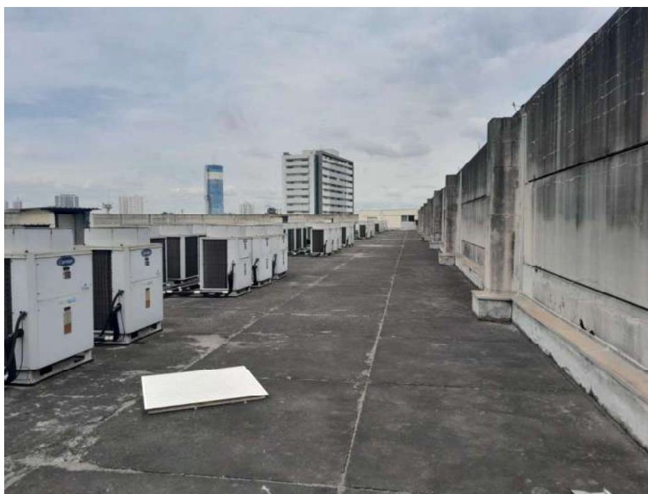
Vista da cobertura.
