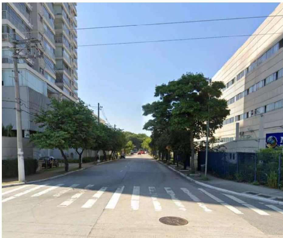
Vista da Rua Elias Antônio Zogbi no trecho do imóvel.
