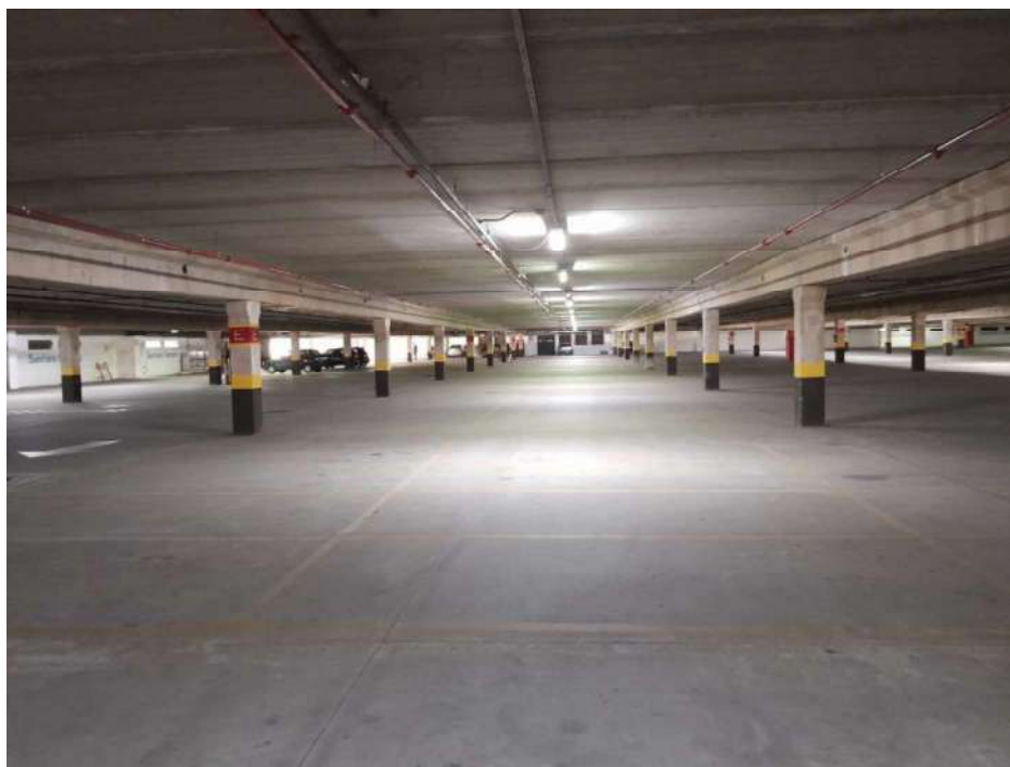
Vista da garagem no pavimento térreo.
