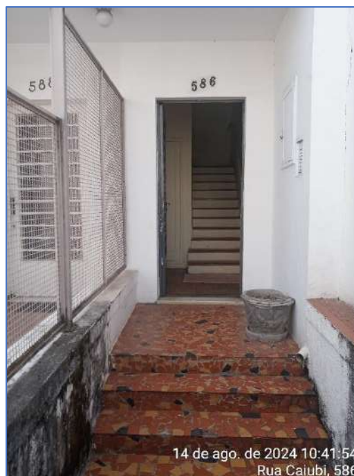
Foto de nº 48 - Escada de acesso.
