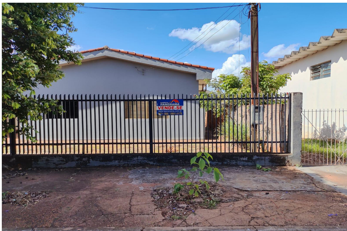
Foto 02. Vista frontal. Rua EMILIO CONDE, n.1.333 - Centro da Cidade
