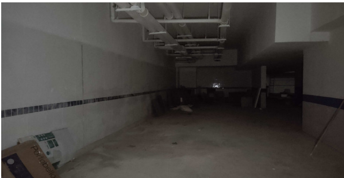
Garagem no subsolo — vagas destinadas ao uso da unidade avaliada.
