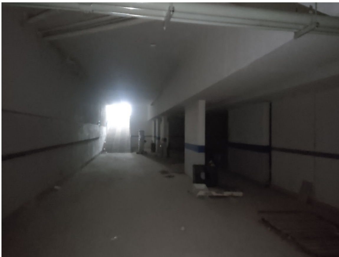
Garagem no subsolo — vagas destinadas ao uso da unidade avaliada.
