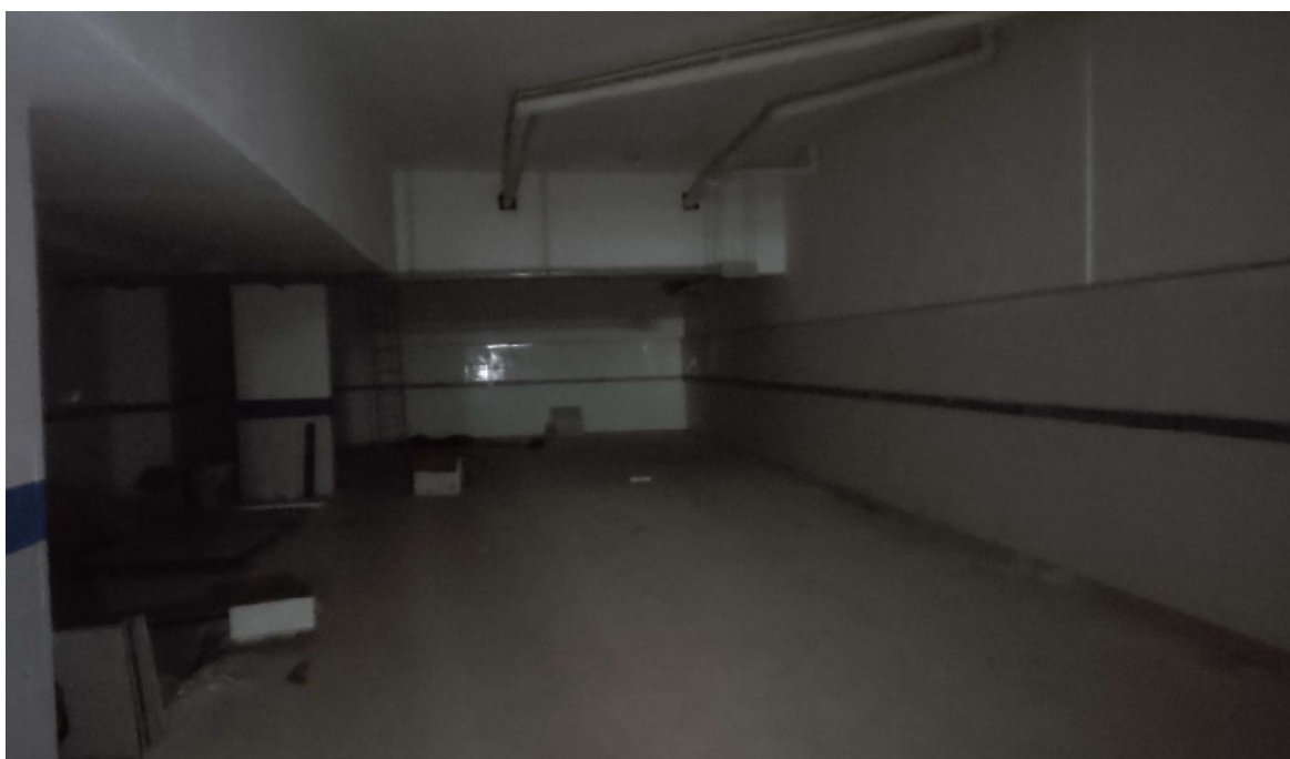
Garagem no subsolo — vagas destinadas ao uso da unidade avaliada.
