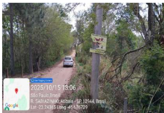
Vista geral do imóvel e região
