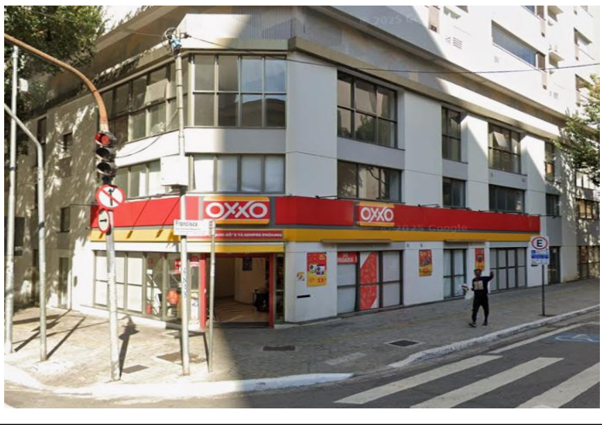
Foto da Fachada do Imóvel
