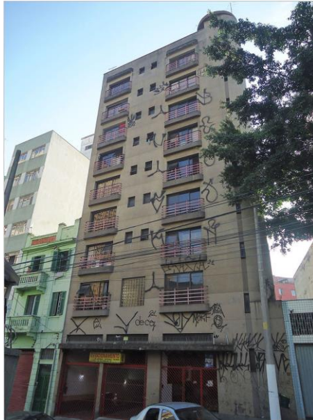
K. RUA DOS CARMELITAS, 109 EDIFÍCIO CARMELITAS RESIDENCE
