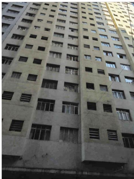
E. RUA HELENA ZERRENER, 53 EDIFÍCIO CASTELINHO
