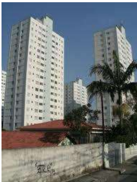
Foto 03 - Fachada do prédio
