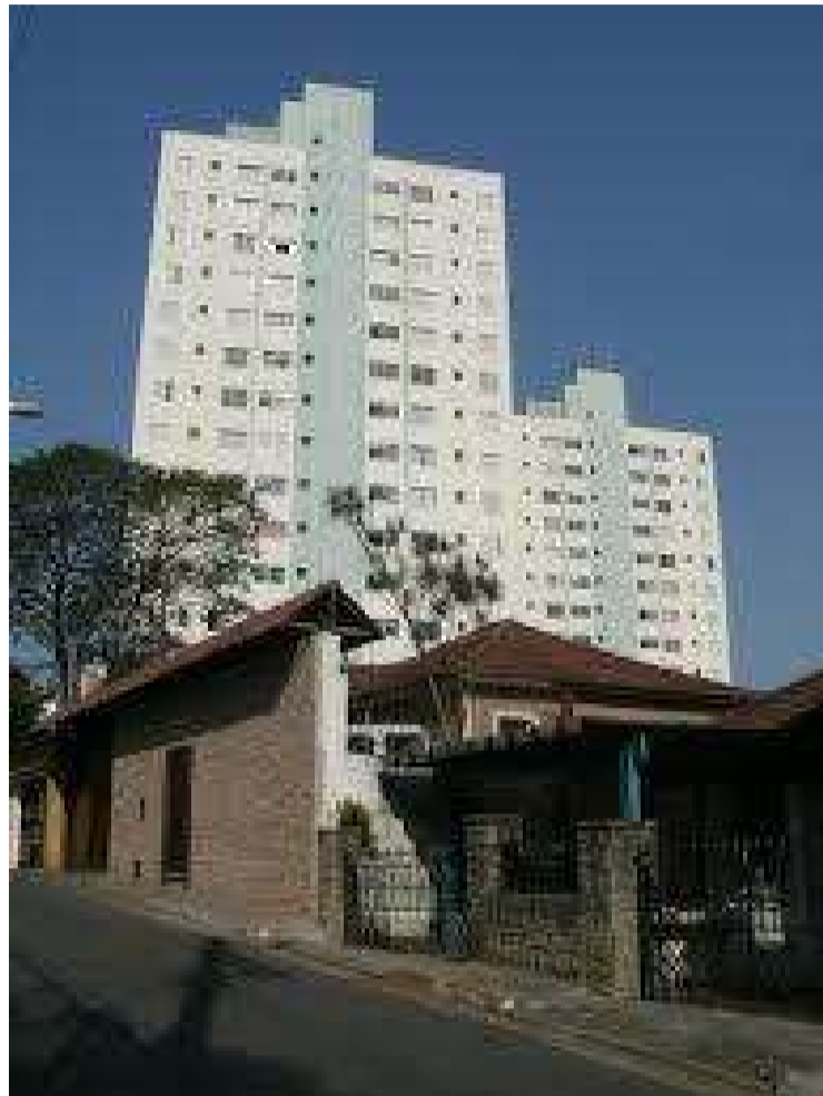
Foto 01 - Fachada do prédio
