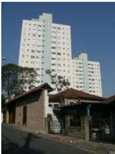
Foto 02 - Fachada do prédio
