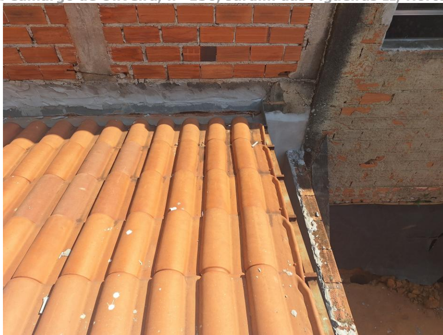
Imagem 91 – Vista Interna – VARANDA. Imóvel verificado durante a DILIGÊNCIA / VISTORIA, pela PERÍCIA DO JUÍZO no local apontado nos autos. Obras em andamento. Trabalhos foram acompanhados pelos representantes do EXECUTADO. Acesso franqueado pelo EXECUTADO. Rua Neusa Camargo de Oliveira, nº 150, Jardim das Figueiras II, Hortolândia/SP.
