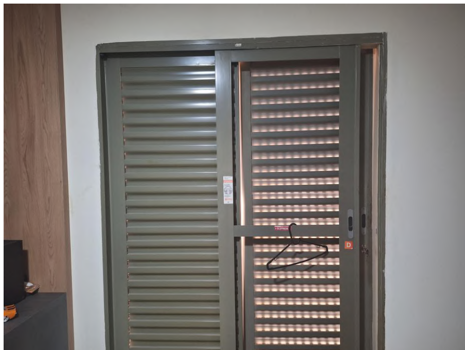
Imagem 56 – Vista Interna – QUARTO. Imóvel verificado durante a DILIGÊNCIA / VISTORIA, pela PERÍCIA DO JUÍZO no local apontado nos autos. Paredes em alvenaria / reboco / pintura. Piso cerâmico. Trabalhos foram acompanhados pelos representantes do EXECUTADO. Acesso franqueado pelo EXECUTADO.
