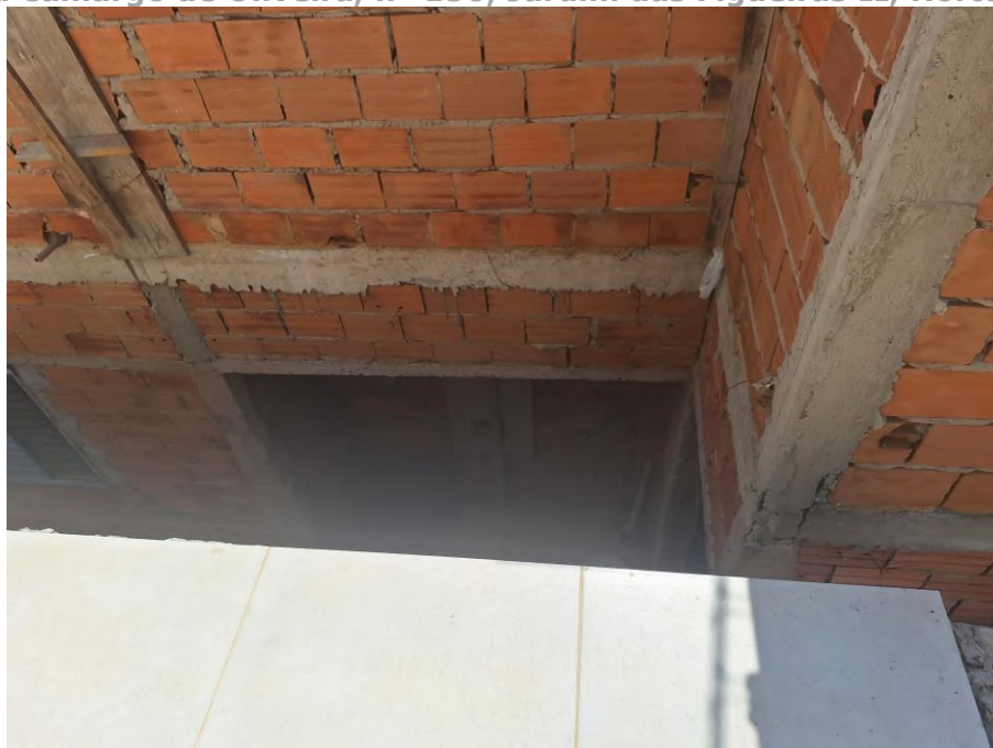
Imagem 71 – Vista Interna – VARANDA. Imóvel verificado durante a DILIGÊNCIA / VISTORIA, pela PERÍCIA DO JUÍZO no local apontado nos autos. Obras em andamento. Piso cerâmico. Trabalhos foram acompanhados pelos representantes do EXECUTADO. Acesso franqueado pelo EXECUTADO. Rua Neusa Camargo de Oliveira, nº 150, Jardim das Figueiras II, Hortolândia/SP.
