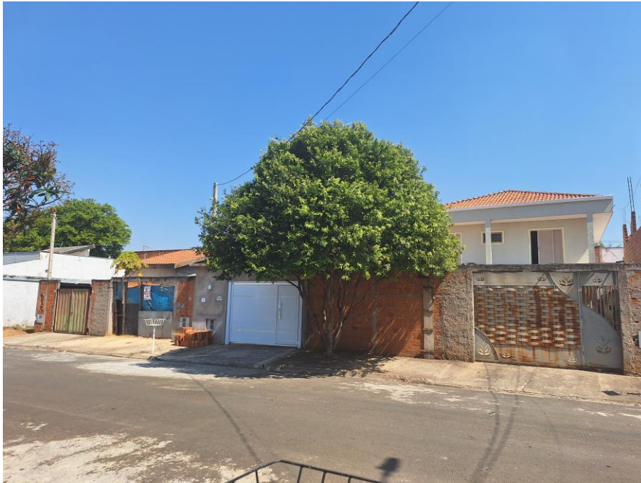
Imagem 14 – Vista Externa – FACHADA PRINCIPAL. Imóvel verificado durante a DILIGÊNCIA / VISTORIA, pela PERÍCIA DO JUÍZO no local apontado nos autos. Muro em alvenaria / reboco. Portão de ferro. Trabalhos foram acompanhados pelos representantes do EXECUTADO. Acesso franqueado pelo EXECUTADO.
