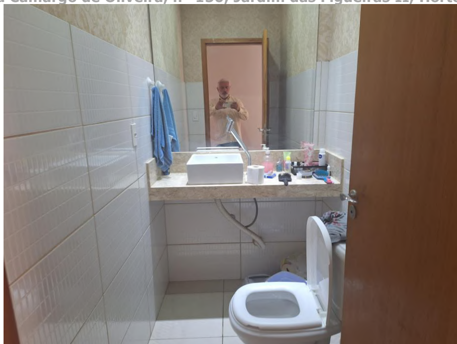
Imagem 41 – Vista Interna – LAVABO. Imóvel verificado durante a DILIGÊNCIA / VISTORIA, pela PERÍCIA DO JUÍZO no local apontado nos autos. Paredes em alvenaria / reboco / pintura. Revestimento e piso cerâmico. Trabalhos foram acompanhados pelos representantes do EXECUTADO. Acesso franqueado pelo EXECUTADO.
