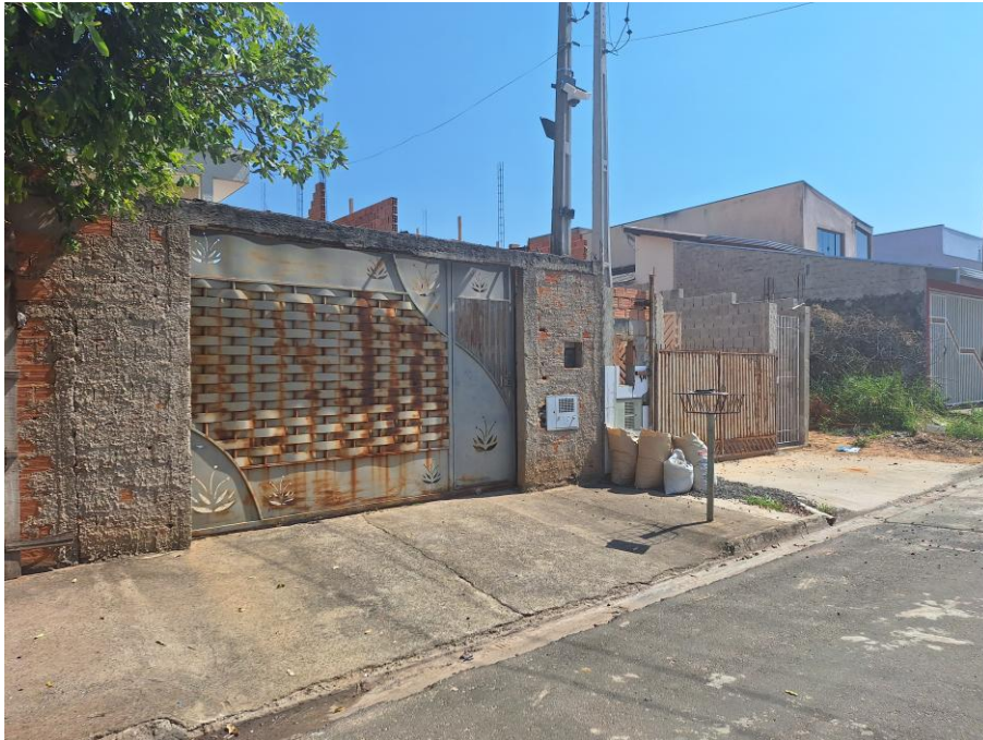
Imagem 18 – Vista Externa – FACHADA PRINCIPAL. Imóvel verificado durante a DILIGÊNCIA / VISTORIA, pela PERÍCIA DO JUÍZO no local apontado nos autos. Muro em alvenaria / reboco. Portão de ferro. Trabalhos foram acompanhados pelos representantes do EXECUTADO. Acesso franqueado pelo EXECUTADO.
