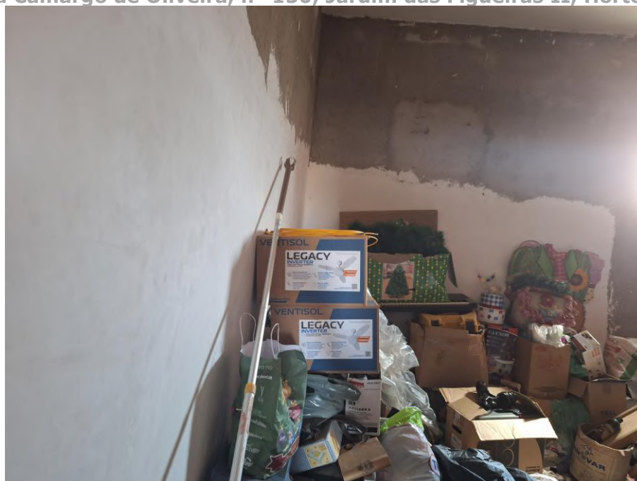
Imagem 83 – Vista Interna – DEPÓSITO DE FERRAMENTAS / TINTAS. Imóvel verificado durante a DILIGÊNCIA / VISTORIA, pela PERÍCIA DO JUÍZO no local apontado nos autos. Paredes em alvenaria / reboco / pintura. Piso cerâmico. Trabalhos foram acompanhados pelos representantes do EXECUTADO. Acesso franqueado pelo EXECUTADO.
