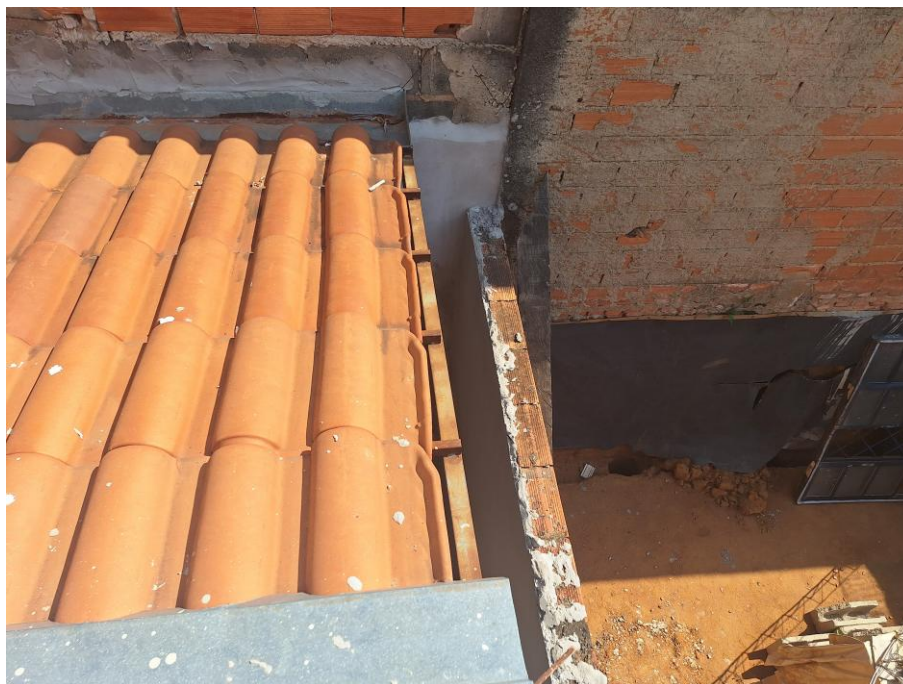
Imagem 92 – Vista Interna – VARANDA. Imóvel verificado durante a DILIGÊNCIA / VISTORIA, pela PERÍCIA DO JUÍZO no local apontado nos autos. Obras em andamento. Trabalhos foram acompanhados pelos representantes do EXECUTADO. Acesso franqueado pelo EXECUTADO. Rua Neusa Camargo de Oliveira, nº 150, Jardim das Figueiras II, Hortolândia/SP.
