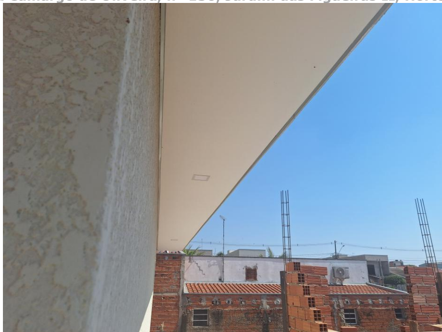
Imagem 69 – Vista Interna – VARANDA. Imóvel verificado durante a DILIGÊNCIA / VISTORIA, pela PERÍCIA DO JUÍZO no local apontado nos autos. Obras em andamento. Piso cerâmico. Trabalhos foram acompanhados pelos representantes do EXECUTADO. Acesso franqueado pelo EXECUTADO. Rua Neusa Camargo de Oliveira, nº 150, Jardim das Figueiras II, Hortolândia/SP.
