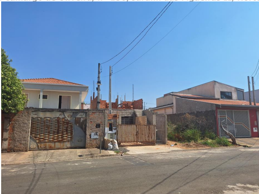
Imagem 15 – Vista Externa – FACHADA PRINCIPAL. Imóvel verificado durante a DILIGÊNCIA / VISTORIA, pela PERÍCIA DO JUÍZO no local apontado nos autos. Muro em alvenaria / reboco. Portão de ferro. Trabalhos foram acompanhados pelos representantes do EXECUTADO. Acesso franqueado pelo EXECUTADO.
