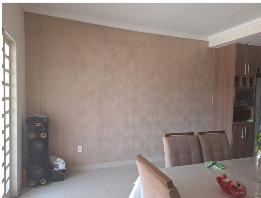
Imagem 42 – Vista Interna – SALA DE JANTAR. Imóvel verificado durante a DILIGÊNCIA / VISTORIA, pela PERÍCIA DO JUÍZO no local apontado nos autos. Paredes em alvenaria / reboco / pintura. Piso cerâmico. Trabalhos foram acompanhados pelos representantes do EXECUTADO. Acesso franqueado pelo EXECUTADO.
