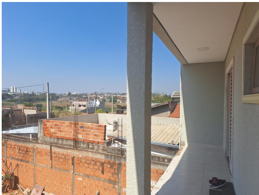
Imagem 62 – Vista Interna – VARANDA. Imóvel verificado durante a DILIGÊNCIA / VISTORIA, pela PERÍCIA DO JUÍZO no local apontado nos autos. Obras em andamento. Piso cerâmico. Trabalhos foram acompanhados pelos representantes do EXECUTADO. Acesso franqueado pelo EXECUTADO. Rua Neusa Camargo de Oliveira, nº 150, Jardim das Figueiras II, Hortolândia/SP.
