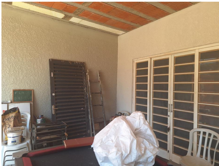
Imagem 30 – Vista Interna – GARAGEM. Imóvel verificado durante a DILIGÊNCIA / VISTORIA, pela PERÍCIA DO JUÍZO no local apontado nos autos. Paredes em alvenaria / reboco / pintura. Piso cimentado. Trabalhos foram acompanhados pelos representantes do EXECUTADO. Acesso franqueado pelo EXECUTADO.
