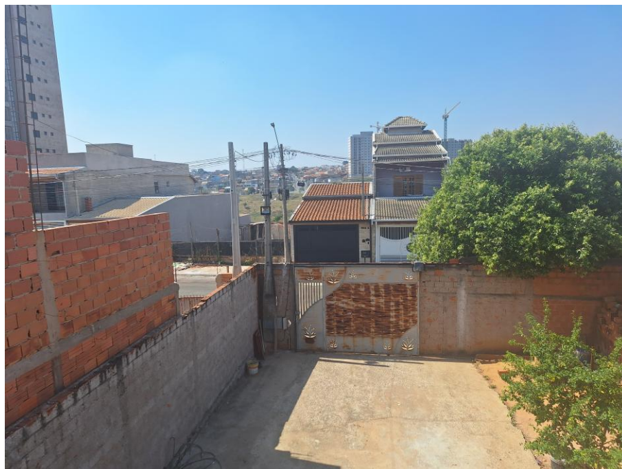
Imagem 64 – Vista Interna – VARANDA – Vista para a garagem. Imóvel verificado durante a DILIGÊNCIA / VISTORIA, pela PERÍCIA DO JUÍZO no local apontado nos autos. Obras em andamento. Piso cerâmico. Trabalhos foram acompanhados pelos representantes do EXECUTADO. Acesso franqueado pelo EXECUTADO.
