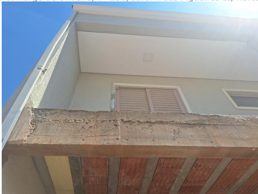
Imagem 27 – Vista Interna – GARAGEM – Vista para piso superior. Imóvel verificado durante a DILIGÊNCIA / VISTORIA, pela PERÍCIA DO JUÍZO no local apontado nos autos. Paredes em alvenaria / reboco. Piso cimentado. Trabalhos foram acompanhados pelos representantes do EXECUTADO. Acesso franqueado pelo EXECUTADO.
