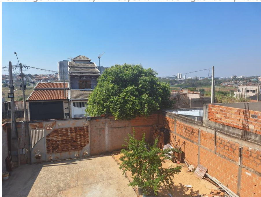
Imagem 63 – Vista Interna – VARANDA – Vista para a garagem. Imóvel verificado durante a DILIGÊNCIA / VISTORIA, pela PERÍCIA DO JUÍZO no local apontado nos autos. Obras em andamento. Piso cerâmico. Trabalhos foram acompanhados pelos representantes do EXECUTADO. Acesso franqueado pelo EXECUTADO. Rua Neusa Camargo de Oliveira, nº 150, Jardim das Figueiras II, Hortolândia/SP.
