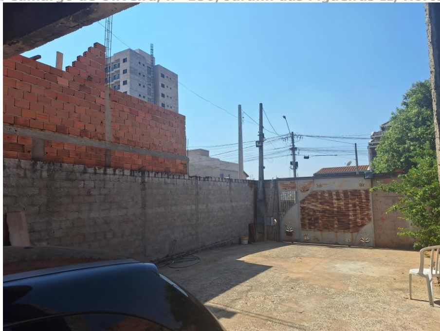
Imagem 33 – Vista Interna – GARAGEM. Imóvel verificado durante a DILIGÊNCIA / VISTORIA, pela PERÍCIA DO JUÍZO no local apontado nos autos. Paredes em alvenaria / reboco. Piso cimentado. Trabalhos foram acompanhados pelos representantes do EXECUTADO. Acesso franqueado pelo EXECUTADO.
