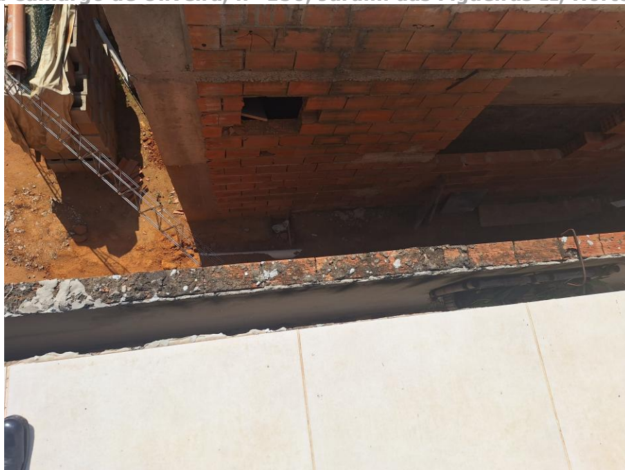
Imagem 95 – Vista Interna – VARANDA. Imóvel verificado durante a DILIGÊNCIA / VISTORIA, pela PERÍCIA DO JUÍZO no local apontado nos autos. Obras em andamento. Trabalhos foram acompanhados pelos representantes do EXECUTADO. Acesso franqueado pelo EXECUTADO. Rua Neusa Camargo de Oliveira, nº 150, Jardim das Figueiras II, Hortolândia/SP.
