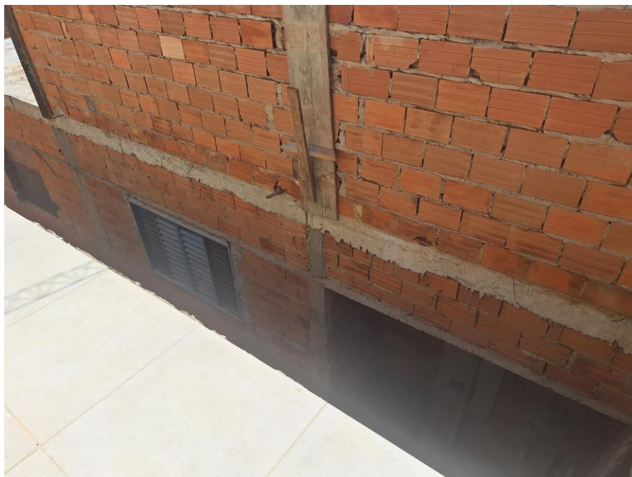
Imagem 70 – Vista Interna – VARANDA. Imóvel verificado durante a DILIGÊNCIA / VISTORIA, pela PERÍCIA DO JUÍZO no local apontado nos autos. Obras em andamento. Piso cerâmico. Trabalhos foram acompanhados pelos representantes do EXECUTADO. Acesso franqueado pelo EXECUTADO. Rua Neusa Camargo de Oliveira, nº 150, Jardim das Figueiras II, Hortolândia/SP.
