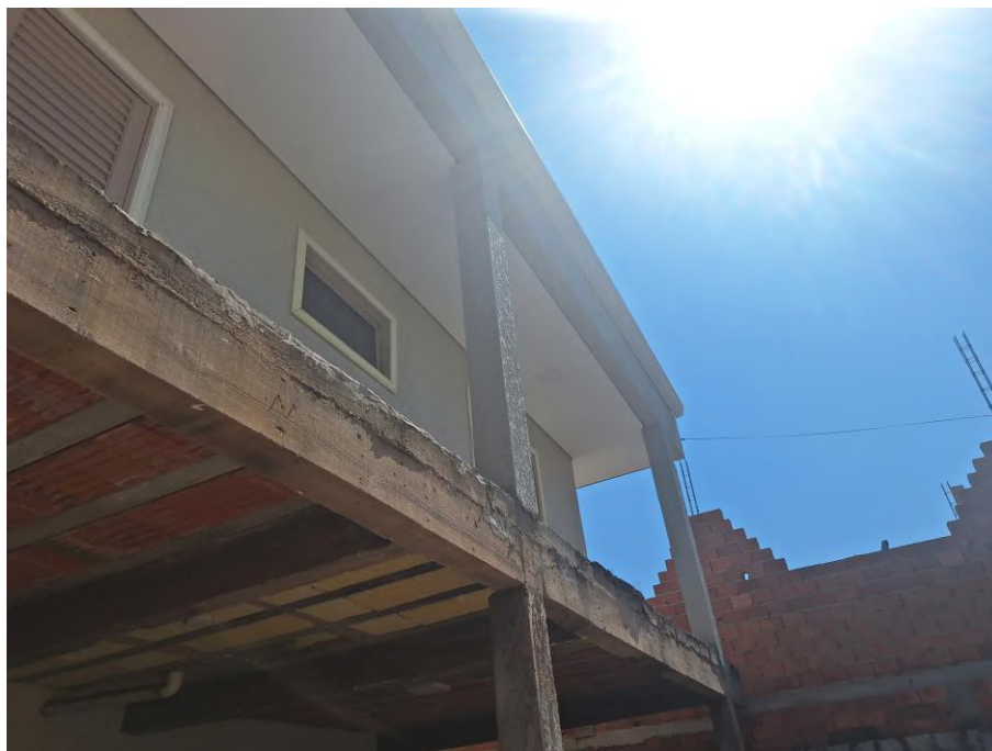
Imagem 26 – Vista Interna – GARAGEM – Vista para piso superior. Imóvel verificado durante a DILIGÊNCIA / VISTORIA, pela PERÍCIA DO JUÍZO no local apontado nos autos. Paredes em alvenaria / reboco. Piso cimentado. Trabalhos foram acompanhados pelos representantes do EXECUTADO. Acesso franqueado pelo EXECUTADO.
