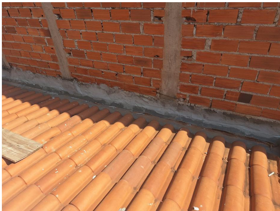
Imagem 90 – Vista Interna – VARANDA. Imóvel verificado durante a DILIGÊNCIA / VISTORIA, pela PERÍCIA DO JUÍZO no local apontado nos autos. Obras em andamento. Trabalhos foram acompanhados pelos representantes do EXECUTADO. Acesso franqueado pelo EXECUTADO. Rua Neusa Camargo de Oliveira, nº 150, Jardim das Figueiras II, Hortolândia/SP.
