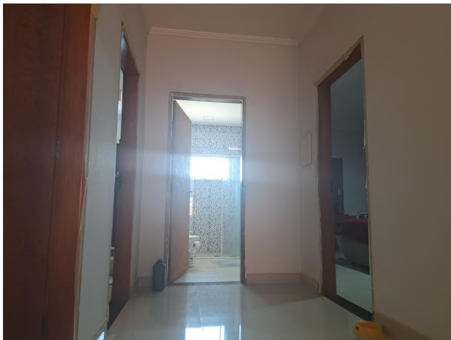
Imagem 50 – Vista Interna – CORREDOR DE CIRCULAÇÃO INTERNA. Imóvel verificado durante a DILIGÊNCIA / VISTORIA, pela PERÍCIA DO JUÍZO no local apontado nos autos. Paredes em alvenaria / reboco / pintura. Piso cerâmico. Trabalhos foram acompanhados pelos representantes do EXECUTADO. Acesso franqueado pelo EXECUTADO.
