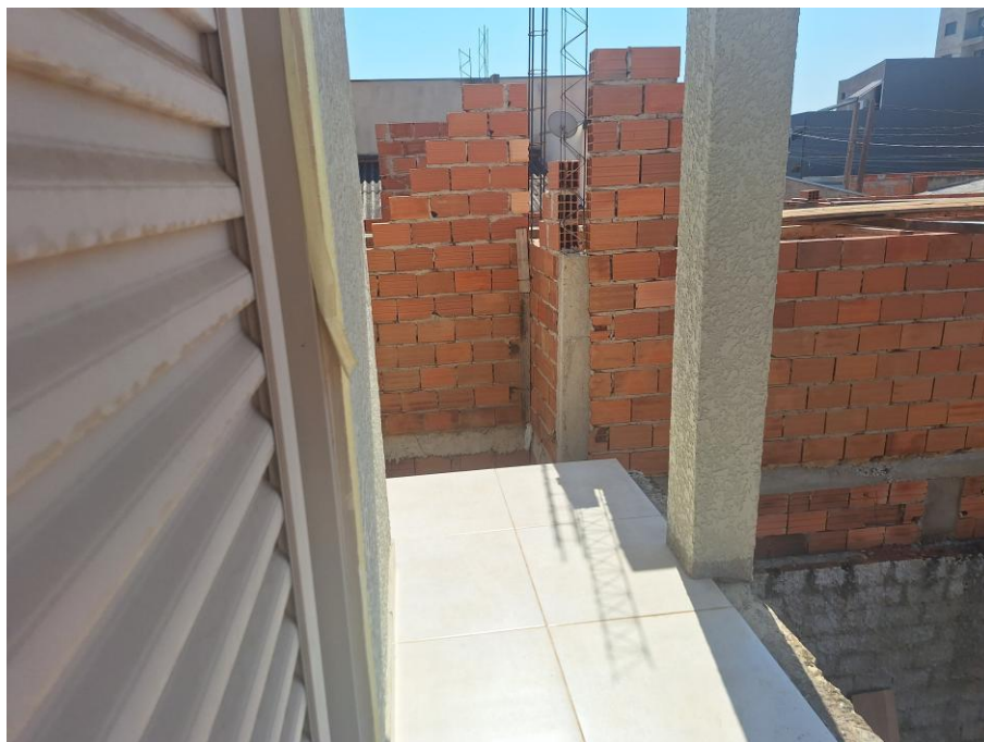
Imagem 60 – Vista Interna – VARANDA. Imóvel verificado durante a DILIGÊNCIA / VISTORIA, pela PERÍCIA DO JUÍZO no local apontado nos autos. Obras em andamento. Piso cerâmico. Trabalhos foram acompanhados pelos representantes do EXECUTADO. Acesso franqueado pelo EXECUTADO. Rua Neusa Camargo de Oliveira, nº 150, Jardim das Figueiras II, Hortolândia/SP.
