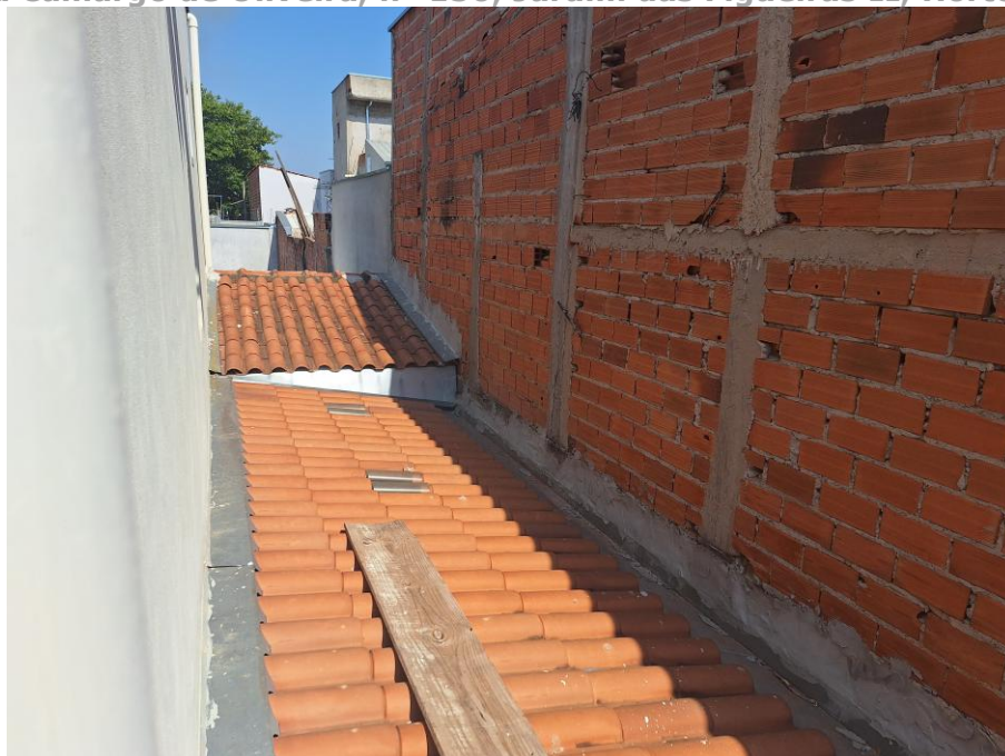
Imagem 89 – Vista Interna – VARANDA. Imóvel verificado durante a DILIGÊNCIA / VISTORIA, pela PERÍCIA DO JUÍZO no local apontado nos autos. Obras em andamento. Trabalhos foram acompanhados pelos representantes do EXECUTADO. Acesso franqueado pelo EXECUTADO. Rua Neusa Camargo de Oliveira, nº 150, Jardim das Figueiras II, Hortolândia/SP.
