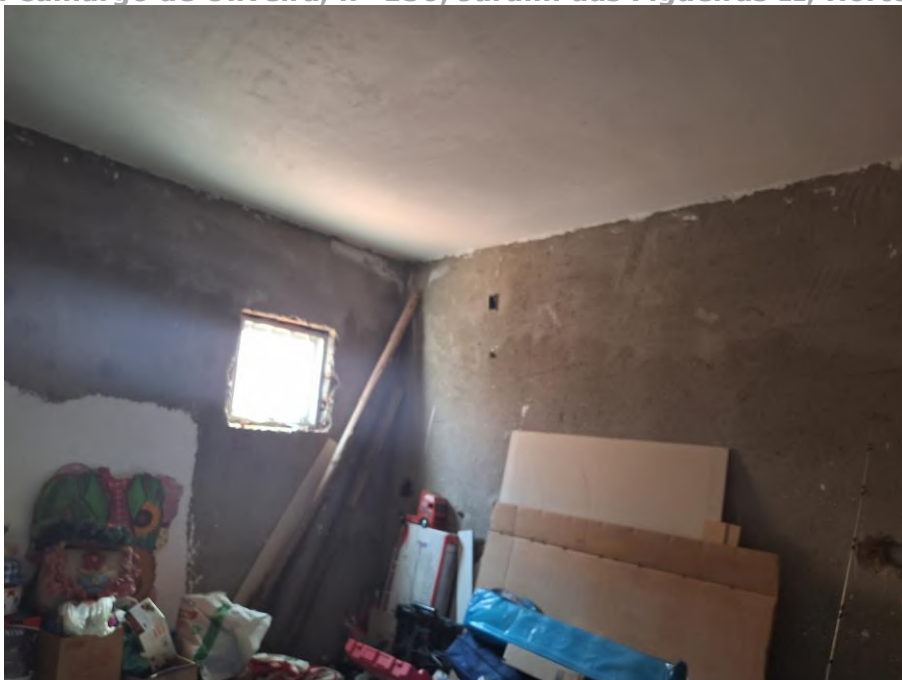
Imagem 85 – Vista Interna – DEPÓSITO DE FERRAMENTAS / TINTAS. Imóvel verificado durante a DILIGÊNCIA / VISTORIA, pela PERÍCIA DO JUÍZO no local apontado nos autos. Paredes em alvenaria / reboco / pintura. Piso cerâmico. Trabalhos foram acompanhados pelos representantes do EXECUTADO. Acesso franqueado pelo EXECUTADO.
