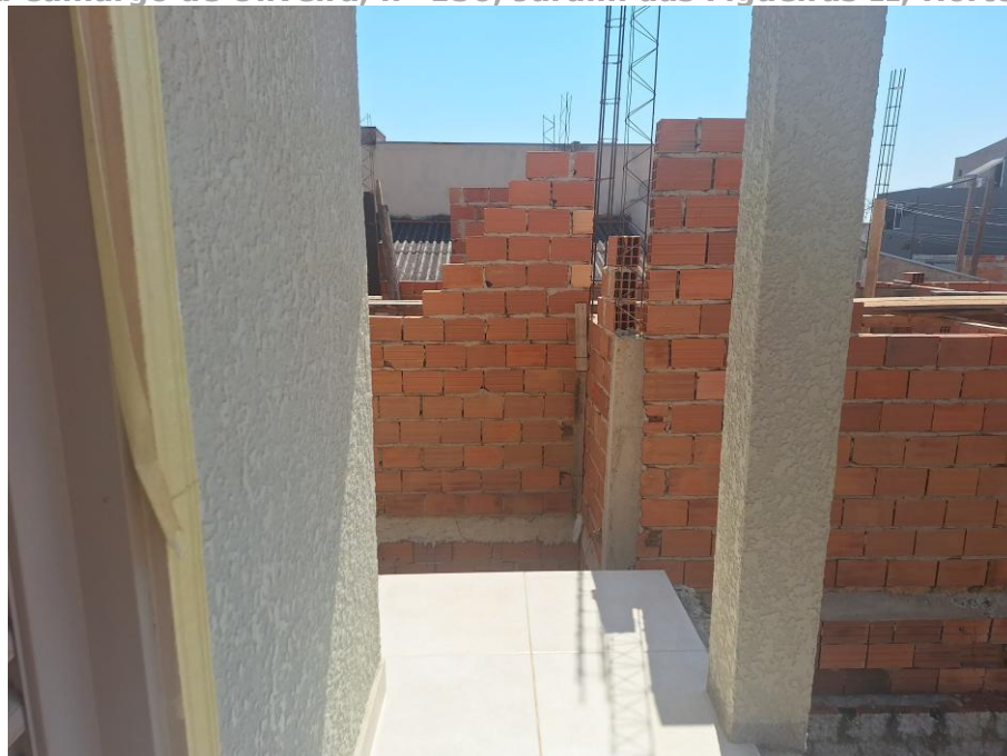
Imagem 65 – Vista Interna – VARANDA. Imóvel verificado durante a DILIGÊNCIA / VISTORIA, pela PERÍCIA DO JUÍZO no local apontado nos autos. Obras em andamento. Piso cerâmico. Trabalhos foram acompanhados pelos representantes do EXECUTADO. Acesso franqueado pelo EXECUTADO.
