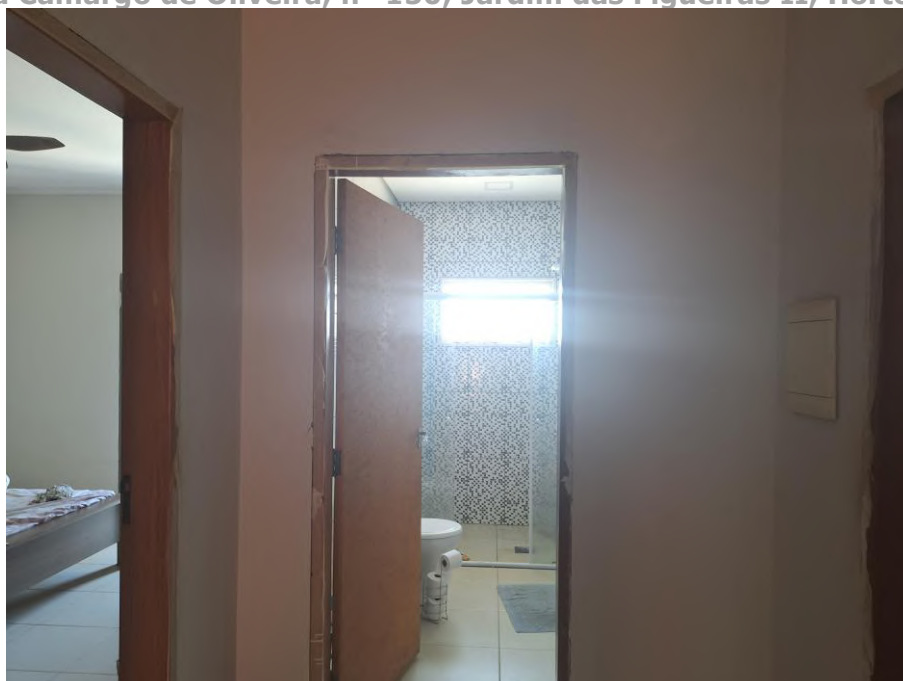
Imagem 51 – Vista Interna – CORREDOR DE CIRCULAÇÃO INTERNA. Imóvel verificado durante a DILIGÊNCIA / VISTORIA, pela PERÍCIA DO JUÍZO no local apontado nos autos. Paredes em alvenaria / reboco / pintura. Piso cerâmico. Trabalhos foram acompanhados pelos representantes do EXECUTADO. Acesso franqueado pelo EXECUTADO.
