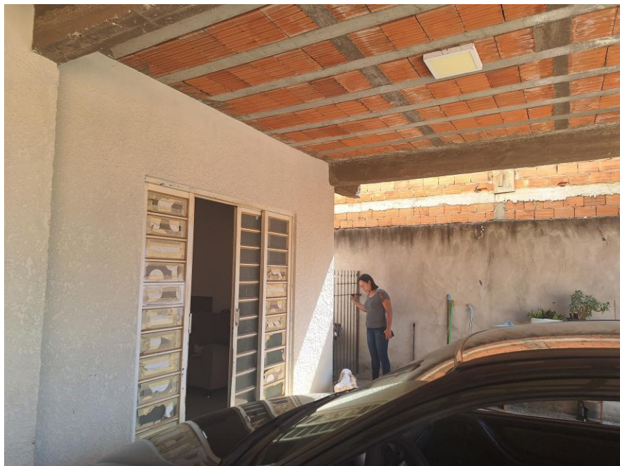
Imagem 12 – Reunião preliminar durante a DILIGÊNCIA / VISTORIA, pela PERÍCIA DO JUÍZO no local apontado nos autos. Trabalho durante a VISTORIA / DILIGÊNCIA foram acompanhados pelos representantes do EXECUTADO. Acesso franqueado pelo EXECUTADO.
