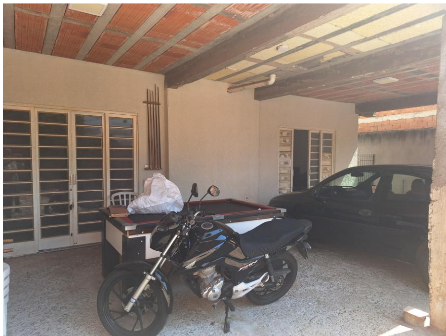
Imagem 24 – Vista Interna – GARAGEM. Imóvel verificado durante a DILIGÊNCIA / VISTORIA, pela PERÍCIA DO JUÍZO no local apontado nos autos. Paredes em alvenaria / reboco / pintura. Piso cimentado. Trabalhos foram acompanhados pelos representantes do EXECUTADO. Acesso franqueado pelo EXECUTADO.
