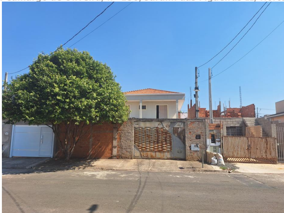
Imagem 13 – Vista Externa – FACHADA PRINCIPAL. Imóvel verificado durante a DILIGÊNCIA / VISTORIA, pela PERÍCIA DO JUÍZO no local apontado nos autos. Muro em alvenaria / reboco. Portão de ferro. Trabalho durante a DILIGÊNCIA / VISTORIA foram acompanhados pelos representantes do EXECUTADO. Acesso franqueado pelo EXECUTADO.
