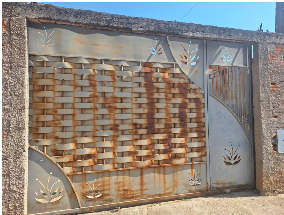
Imagem 20 – Vista Externa – FACHADA PRINCIPAL. Imóvel verificado durante a DILIGÊNCIA / VISTORIA, pela PERÍCIA DO JUÍZO no local apontado nos autos. Muro em alvenaria / reboco. Portão de ferro. Trabalhos foram acompanhados pelos representantes do EXECUTADO. Acesso franqueado pelo EXECUTADO.
