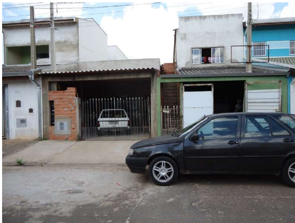
Fachada do imóvel avaliando
