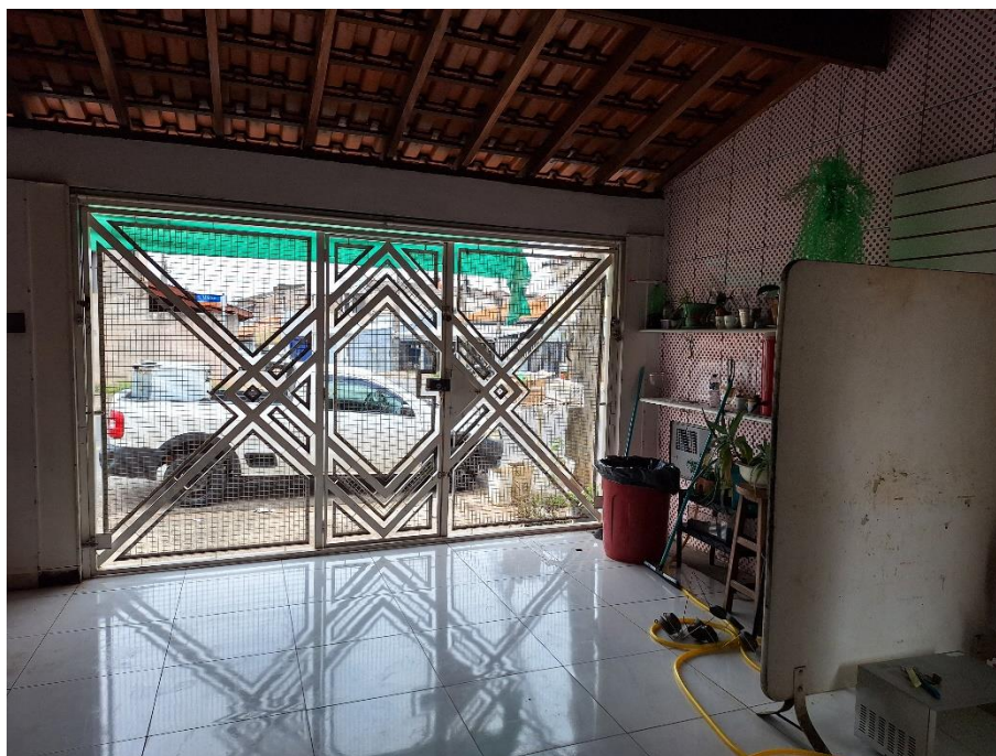
Imagem 20 – Vista Interna – SALÃO COMERCIAL. Imóvel verificado durante a DILIGÊNCIA / VISTORIA, pela PERÍCIA DO JUÍZO no local apontado nos autos. Estrutura em alvenaria / reboco / pintura. Piso cerâmico. Acesso franqueado pela EXECUTADA.
