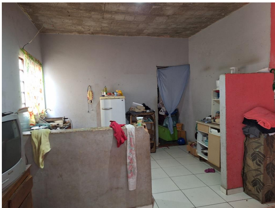
Imagem 75 – Vista Interna – RESIDÊNCIA – Vista para COZINHA. Imóvel verificado durante a DILIGÊNCIA / VISTORIA, pela PERÍCIA DO JUÍZO no local apontado nos autos. Estrutura em alvenaria / reboco / pintura. Piso cerâmico. Acesso franqueado pela EXECUTADA.
