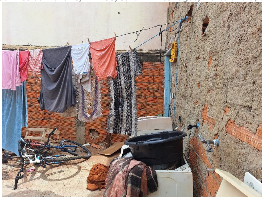
Imagem 94 – Vista Interna – RESIDÊNCIA – QUINTAL / LAVANDERIA / ÁREA DE SERVIÇO. Imóvel verificado durante a DILIGÊNCIA / VISTORIA, pela PERÍCIA DO JUÍZO no local apontado nos autos. Estrutura em alvenaria / reboco. Piso cimentado. Acesso franqueado pela EXECUTADA.
