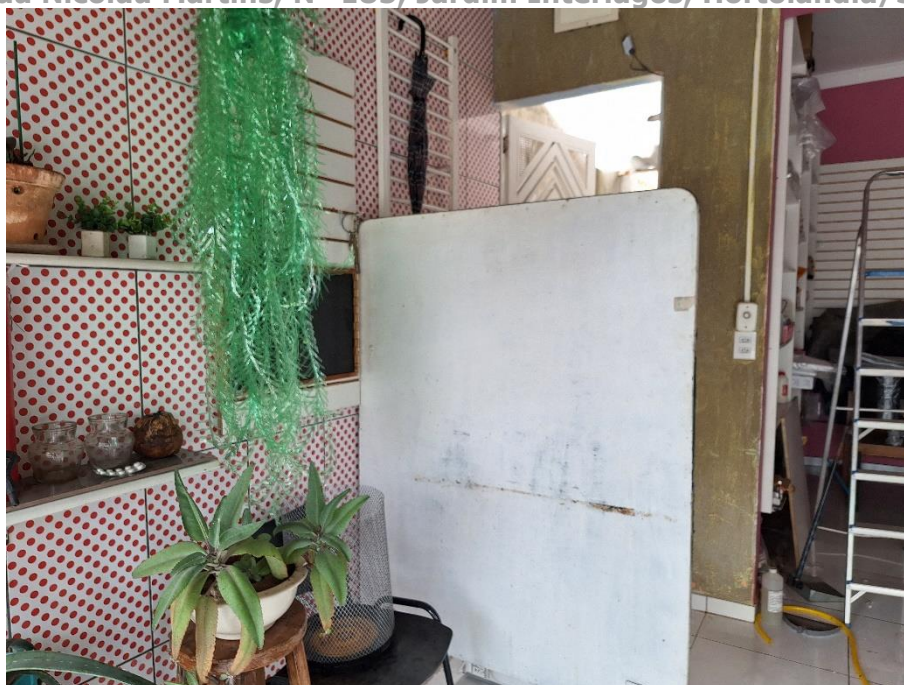
Imagem 17 – Vista Interna – SALÃO COMERCIAL. Imóvel verificado durante a DILIGÊNCIA / VISTORIA, pela PERÍCIA DO JUÍZO no local apontado nos autos. Estrutura em alvenaria / reboco / pintura. Piso cerâmico.
