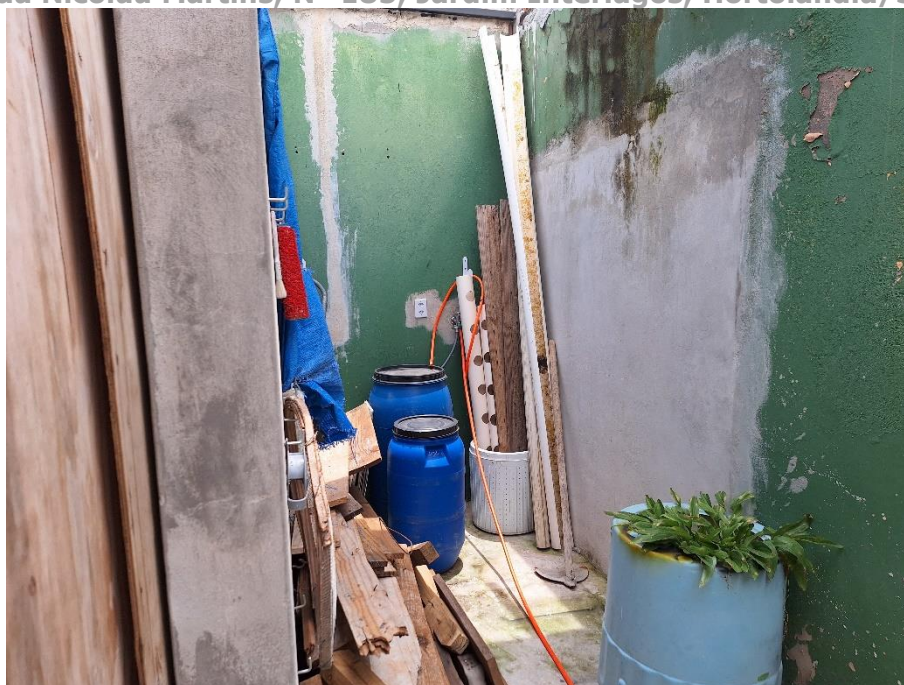
Imagem 63 – Vista Interna – LAVANDERIA / ÁREA DE SERVIÇO. Imóvel verificado durante a DILIGÊNCIA / VISTORIA, pela PERÍCIA DO JUÍZO no local apontado nos autos. Estrutura em alvenaria / reboco. Piso cimentado. Acesso franqueado pela EXECUTADA.
