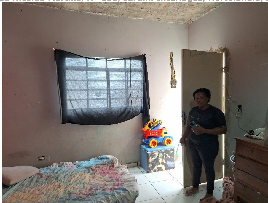
Imagem 76 – Vista Interna – RESIDÊNCIA – Vista para QUARTO / SALA DE ESTAR. Imóvel verificado durante a DILIGÊNCIA / VISTORIA, pela PERÍCIA DO JUÍZO no local apontado nos autos. Estrutura em alvenaria / reboco / pintura. Piso cerâmico. Esquadria de ferro. Acesso franqueado pela EXECUTADA.
