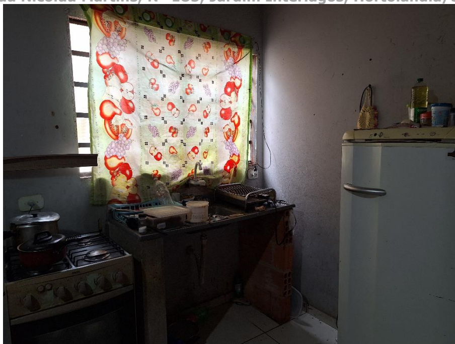
Imagem 80 – Vista Interna – RESIDÊNCIA – COZINHA. Imóvel verificado durante a DILIGÊNCIA / VISTORIA, pela PERÍCIA DO JUÍZO no local apontado nos autos. Estrutura em alvenaria / reboco / pintura. Piso cerâmico. Esquadria de ferro. Acesso franqueado pela EXECUTADA.
