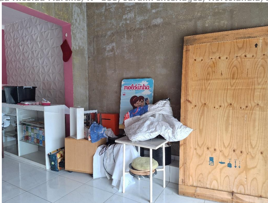
Imagem 19 – Vista Interna – SALÃO COMERCIAL. Imóvel verificado durante a DILIGÊNCIA / VISTORIA, pela PERÍCIA DO JUÍZO no local apontado nos autos. Estrutura em alvenaria / reboco / pintura. Piso cerâmico. Acesso franqueado pela EXECUTADA.
