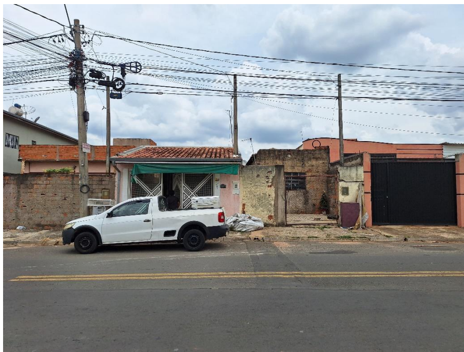
Imagem 08 – Vista Externa – FACHADA PRINCIPAL – SALÃO COMERCIAL. Imóvel verificado durante a DILIGÊNCIA / VISTORIA, pela PERÍCIA DO JUÍZO no local apontado nos autos. Muro em alvenaria / reboco / pintura. Portão de ferro. Acesso franqueado pela EXECUTADA.
