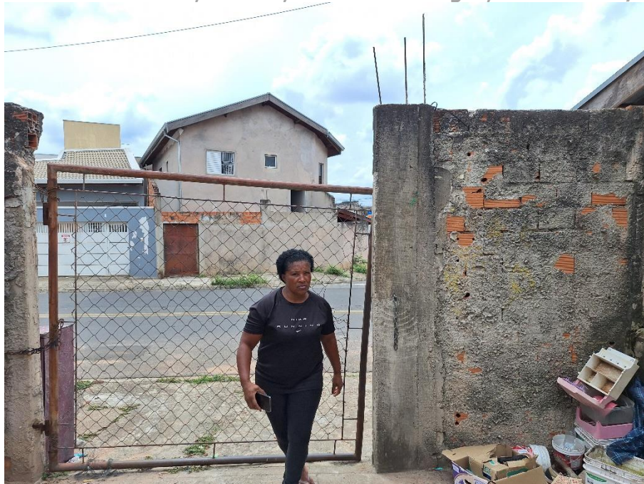
Imagem 72 – Vista Interna – RESIDÊNCIA – GARAGEM / QUINTAL. Imóvel verificado durante a DILIGÊNCIA / VISTORIA, pela PERÍCIA DO JUÍZO no local apontado nos autos. Estrutura em alvenaria / reboco. Piso cimentado. Portão de ferro. Acesso franqueado pela EXECUTADA.
