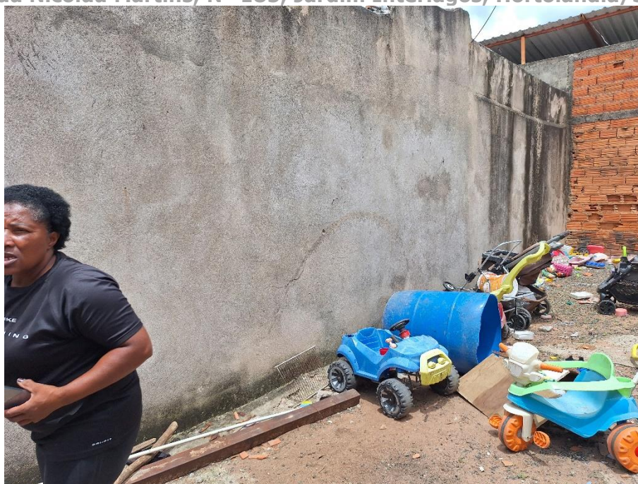
Imagem 96 – Vista Interna – RESIDÊNCIA – QUINTAL / LAVANDERIA / ÁREA DE SERVIÇO. Imóvel verificado durante a DILIGÊNCIA / VISTORIA, pela PERÍCIA DO JUÍZO no local apontado nos autos. Estrutura em alvenaria / reboco. Piso cimentado. Acesso franqueado pela EXECUTADA.
