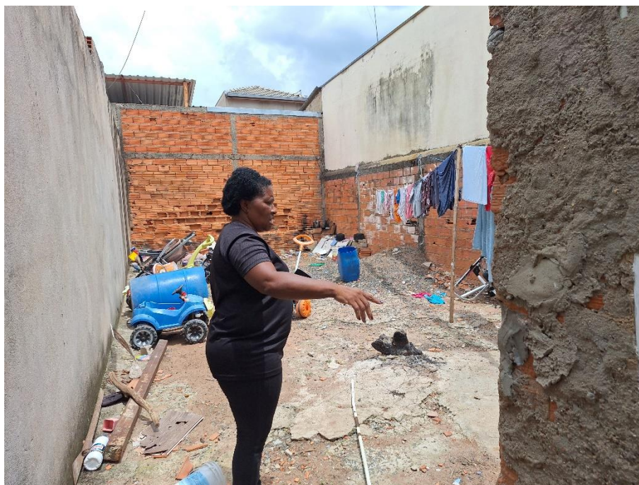
Imagem 93 – Vista Interna – RESIDÊNCIA – QUINTAL / LAVANDERIA / ÁREA DE SERVIÇO. Imóvel verificado durante a DILIGÊNCIA / VISTORIA, pela PERÍCIA DO JUÍZO no local apontado nos autos. Estrutura em alvenaria / reboco. Piso cimentado. Acesso franqueado pela EXECUTADA.
