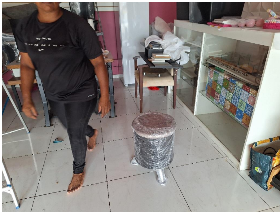
Imagem 24 – Vista Interna – SALÃO COMERCIAL. Imóvel verificado durante a DILIGÊNCIA / VISTORIA, pela PERÍCIA DO JUÍZO no local apontado nos autos. Estrutura em alvenaria / reboco / pintura. Piso cerâmico. Acesso franqueado pela EXECUTADA.
