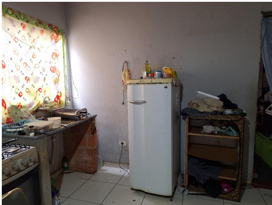
Imagem 81 – Vista Interna – RESIDÊNCIA – COZINHA. Imóvel verificado durante a DILIGÊNCIA / VISTORIA, pela PERÍCIA DO JUÍZO no local apontado nos autos. Estrutura em alvenaria / reboco / pintura. Piso cerâmico. Esquadria de ferro. Acesso franqueado pela EXECUTADA.
