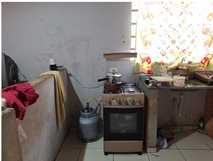
Imagem 79 – Vista Interna – RESIDÊNCIA – COZINHA. Imóvel verificado durante a DILIGÊNCIA / VISTORIA, pela PERÍCIA DO JUÍZO no local apontado nos autos. Estrutura em alvenaria / reboco / pintura. Piso cerâmico. Esquadria de ferro. Acesso franqueado pela EXECUTADA.
