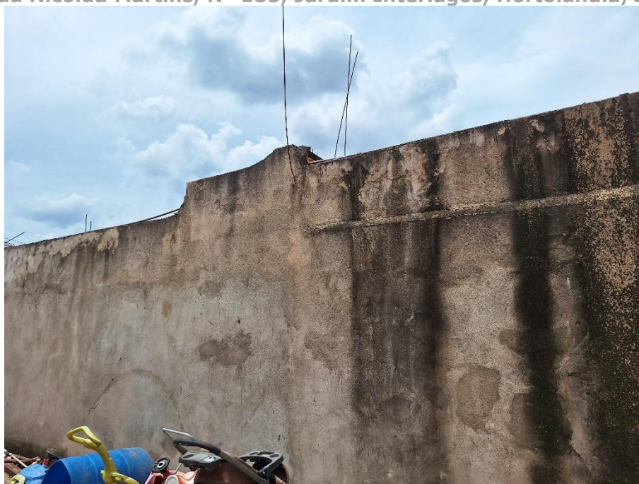
Imagem 100 – Vista Interna – RESIDÊNCIA – QUINTAL / LAVANDERIA / ÁREA DE SERVIÇO. Imóvel verificado durante a DILIGÊNCIA / VISTORIA, pela PERÍCIA DO JUÍZO no local apontado nos autos. Muro em alvenaria / reboco. Piso cimentado. Acesso franqueado pela EXECUTADA.
