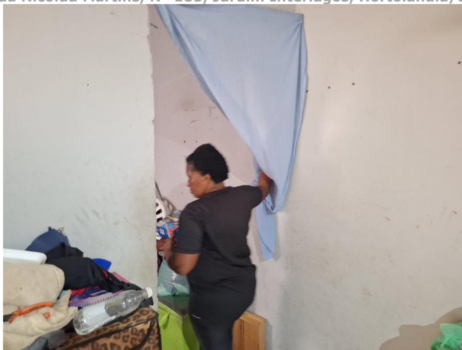
Imagem 84 – Vista Interna – RESIDÊNCIA – COZINHA. Imóvel verificado durante a DILIGÊNCIA / VISTORIA, pela PERÍCIA DO JUÍZO no local apontado nos autos. Estrutura em alvenaria / reboco / pintura. Piso cerâmico. Esquadria de ferro. Acesso franqueado pela EXECUTADA.
