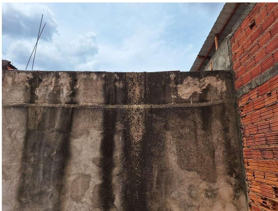
Imagem 101 – Vista Interna – RESIDÊNCIA – QUINTAL / LAVANDERIA / ÁREA DE SERVIÇO. Imóvel verificado durante a DILIGÊNCIA / VISTORIA, pela PERÍCIA DO JUÍZO no local apontado nos autos. Muro em alvenaria / reboco. Piso cimentado. Acesso franqueado pela EXECUTADA.
