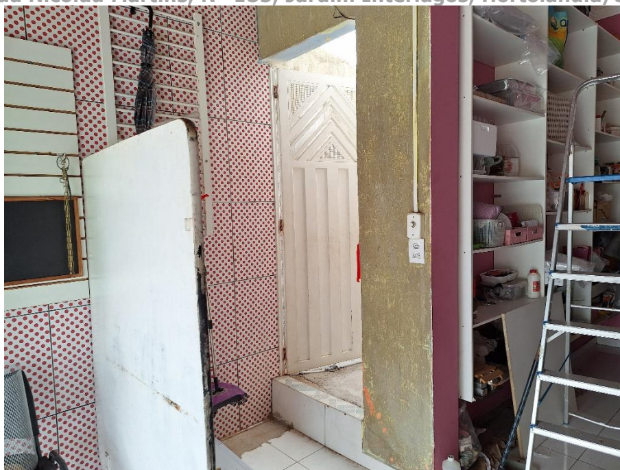
Imagem 27 – Vista Interna – SALÃO COMERCIAL. Imóvel verificado durante a DILIGÊNCIA / VISTORIA, pela PERÍCIA DO JUÍZO no local apontado nos autos. Estrutura em alvenaria / reboco / pintura. Piso cerâmico. Acesso franqueado pela EXECUTADA.
