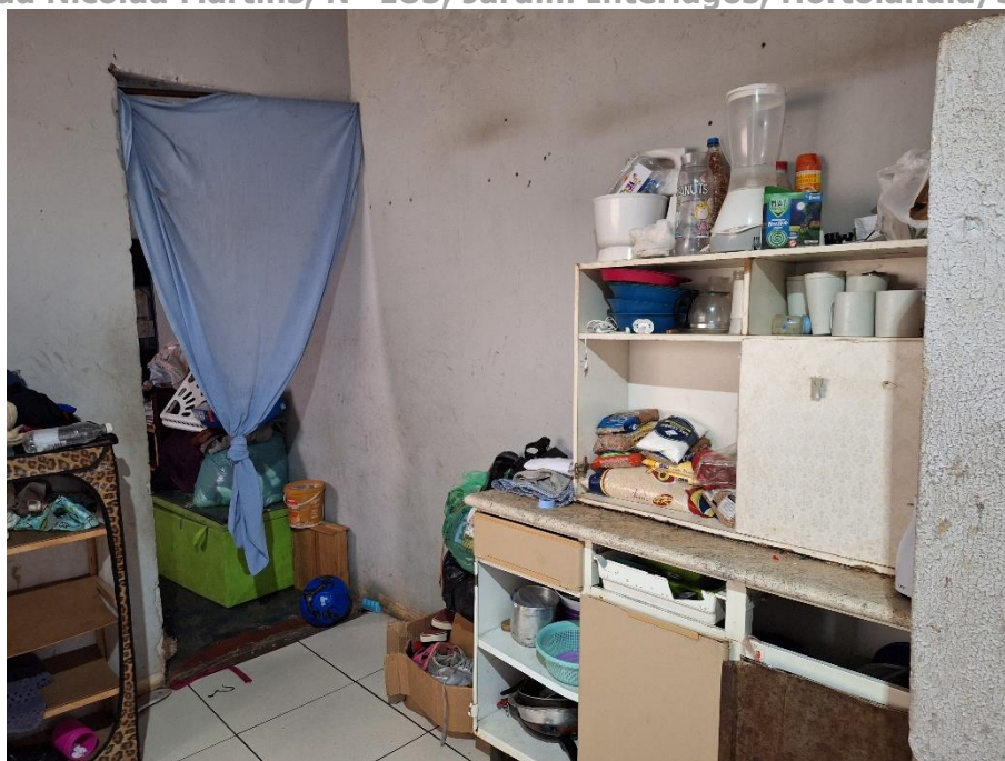
Imagem 82 – Vista Interna – RESIDÊNCIA – COZINHA. Imóvel verificado durante a DILIGÊNCIA / VISTORIA, pela PERÍCIA DO JUÍZO no local apontado nos autos. Estrutura em alvenaria / reboco / pintura. Piso cerâmico. Esquadria de ferro. Acesso franqueado pela EXECUTADA.
