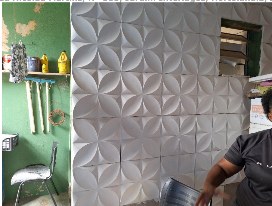
Imagem 61 – Vista Interna – LAVANDERIA / ÁREA DE SERVIÇO. Imóvel verificado durante a DILIGÊNCIA / VISTORIA, pela PERÍCIA DO JUÍZO no local apontado nos autos. Estrutura em alvenaria / reboco. Piso cimentado. Revestimento em gesso. Acesso franqueado pela EXECUTADA.
