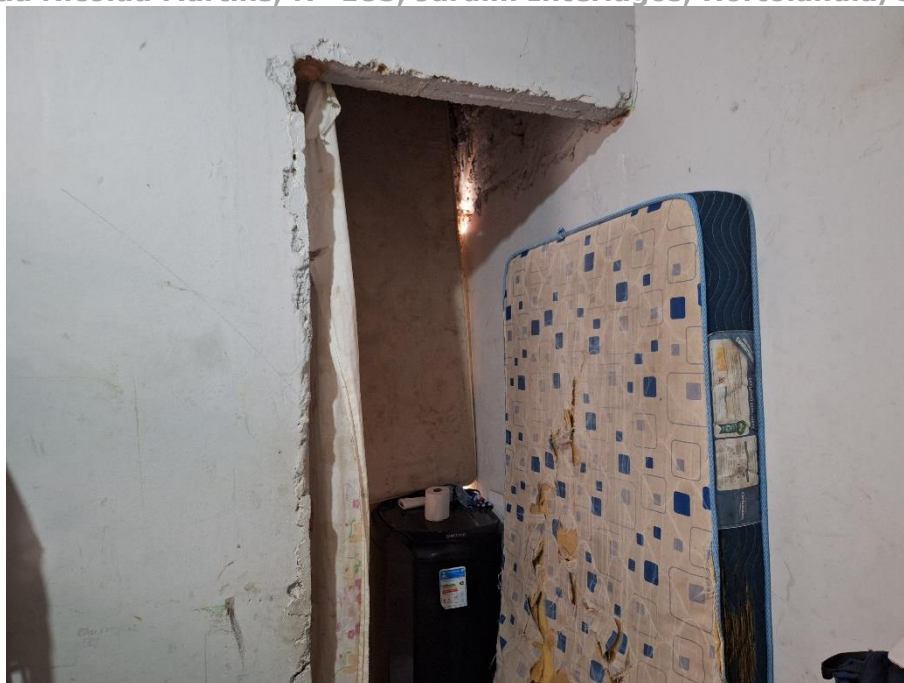
Imagem 90 – Vista Interna – RESIDÊNCIA – QUARTO. Imóvel verificado durante a DILIGÊNCIA / VISTORIA, pela PERÍCIA DO JUÍZO no local apontado nos autos. Estrutura em alvenaria / reboco / pintura. Piso cerâmico. Esquadria de ferro. Acesso franqueado pela EXECUTADA.
