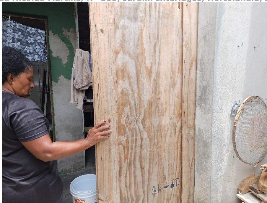
Imagem 55 – Vista Interna – QUINTAL. Imóvel verificado durante a DILIGÊNCIA / VISTORIA, pela PERÍCIA DO JUÍZO no local apontado nos autos. Estrutura em alvenaria / reboco. Piso cimentado. Acesso franqueado pela EXECUTADA.
