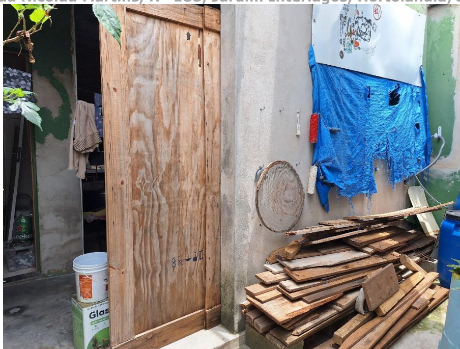
Imagem 53 – Vista Interna – QUINTAL. Imóvel verificado durante a DILIGÊNCIA / VISTORIA, pela PERÍCIA DO JUÍZO no local apontado nos autos. Estrutura em alvenaria / reboco. Piso cimentado. Acesso franqueado pela EXECUTADA.
