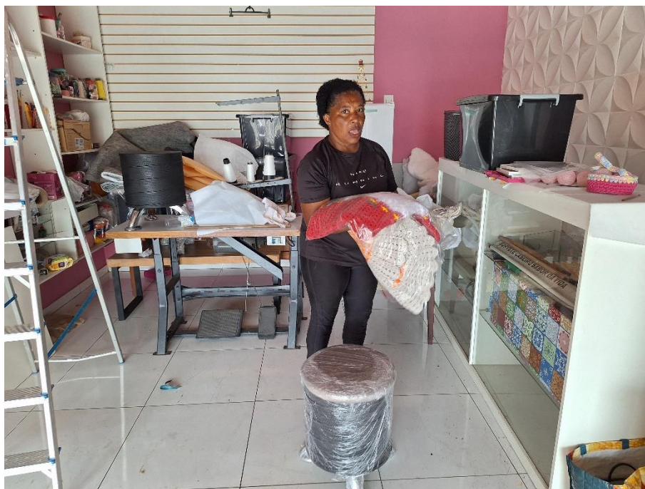
Imagem 26 – Vista Interna – SALÃO COMERCIAL. Imóvel verificado durante a DILIGÊNCIA / VISTORIA, pela PERÍCIA DO JUÍZO no local apontado nos autos. Estrutura em alvenaria / reboco / pintura. Piso cerâmico. Acesso franqueado pela EXECUTADA.
