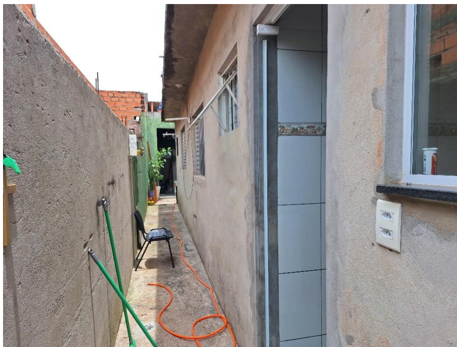
Imagem 30 – Vista Interna – CORREDOR DE CIRCULAÇÃO. Imóvel verificado durante a DILIGÊNCIA / VISTORIA, pela PERÍCIA DO JUÍZO no local apontado nos autos. Estrutura em alvenaria / reboco. Piso cimentado. Acesso franqueado pela EXECUTADA.
