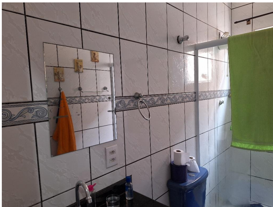
Imagem 38 – Vista Interna – RESIDÊNCIA – BANHEIRO. Imóvel verificado durante a DILIGÊNCIA / VISTORIA, pela PERÍCIA DO JUÍZO no local apontado nos autos. Estrutura em alvenaria / reboco / pintura. Piso e revestimento cerâmico. Acesso franqueado pela EXECUTADA.
