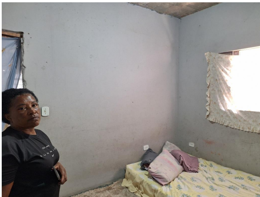
Imagem 87 – Vista Interna – RESIDÊNCIA – QUARTO. Imóvel verificado durante a DILIGÊNCIA / VISTORIA, pela PERÍCIA DO JUÍZO no local apontado nos autos. Estrutura em alvenaria / reboco / pintura. Piso cerâmico. Esquadria de ferro. Acesso franqueado pela EXECUTADA.
