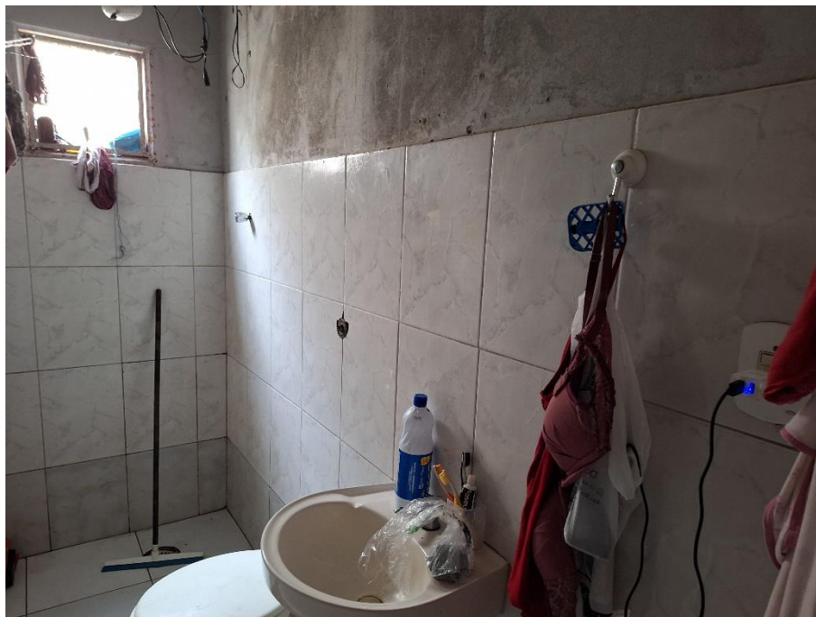
Imagem 89 – Vista Interna – RESIDÊNCIA – BANHEIRO. Imóvel verificado durante a DILIGÊNCIA / VISTORIA, pela PERÍCIA DO JUÍZO no local apontado nos autos. Estrutura em alvenaria / reboco / pintura. Piso e revestimento cerâmico. Acesso franqueado pela EXECUTADA.
