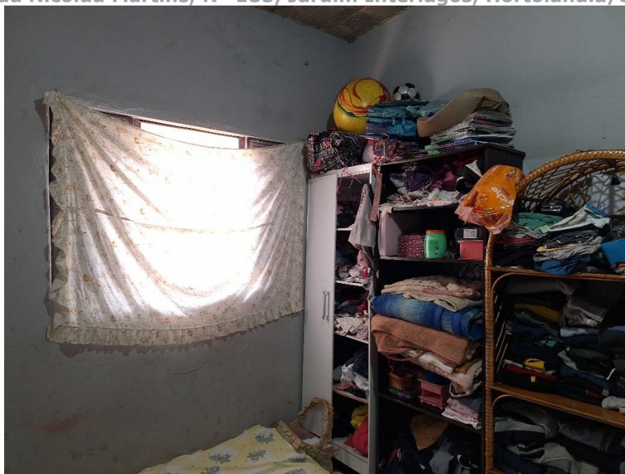
Imagem 86 – Vista Interna – RESIDÊNCIA – QUARTO. Imóvel verificado durante a DILIGÊNCIA / VISTORIA, pela PERÍCIA DO JUÍZO no local apontado nos autos. Estrutura em alvenaria / reboco / pintura. Piso cerâmico. Esquadria de ferro. Acesso franqueado pela EXECUTADA.
