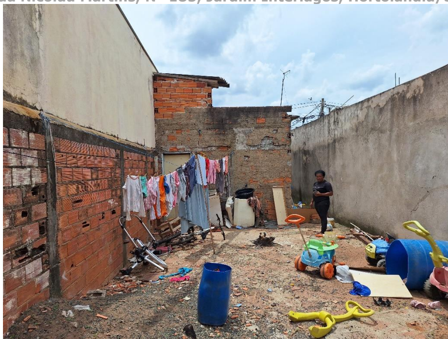
Imagem 98 – Vista Interna – RESIDÊNCIA – QUINTAL / LAVANDERIA / ÁREA DE SERVIÇO. Imóvel verificado durante a DILIGÊNCIA / VISTORIA, pela PERÍCIA DO JUÍZO no local apontado nos autos. Estrutura em alvenaria / reboco. Piso cimentado. Acesso franqueado pela EXECUTADA.
