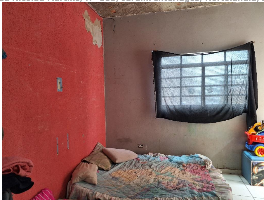
Imagem 78 – Vista Interna – RESIDÊNCIA – Vista para QUARTO / SALA DE ESTAR. Imóvel verificado durante a DILIGÊNCIA / VISTORIA, pela PERÍCIA DO JUÍZO no local apontado nos autos. Estrutura em alvenaria / reboco / pintura. Piso cerâmico. Esquadria de ferro.
