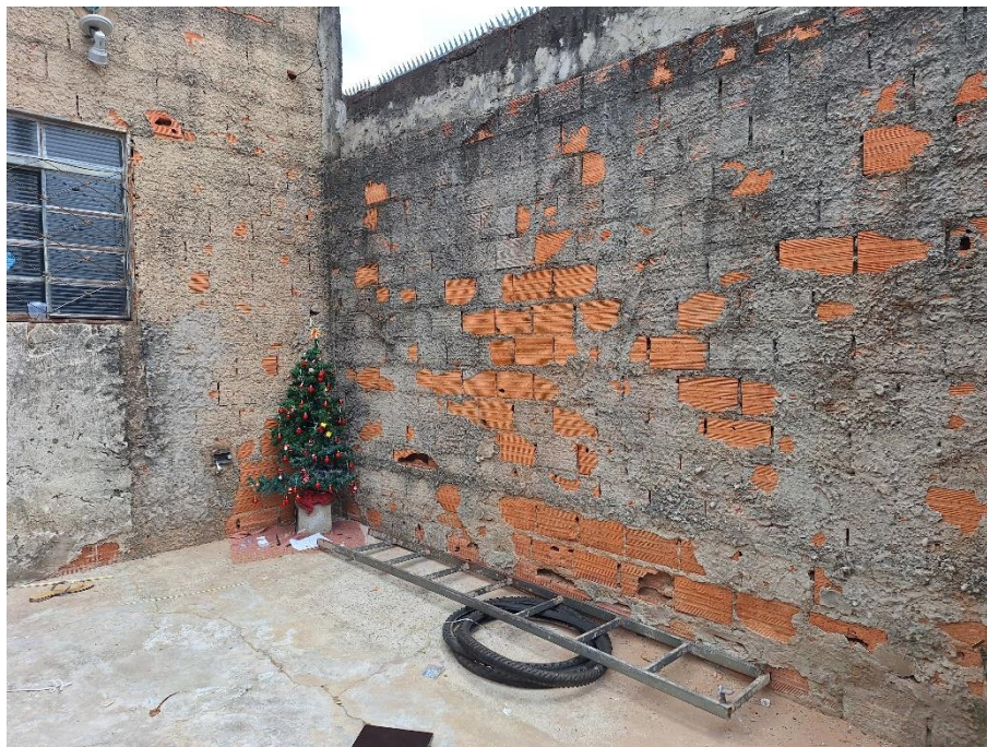
Imagem 69 – Vista Interna – RESIDÊNCIA – GARAGEM / QUINTAL. Imóvel verificado durante a DILIGÊNCIA / VISTORIA, pela PERÍCIA DO JUÍZO no local apontado nos autos. Muro em alvenaria / reboco. Piso cimentado. Acesso franqueado pela EXECUTADA.
