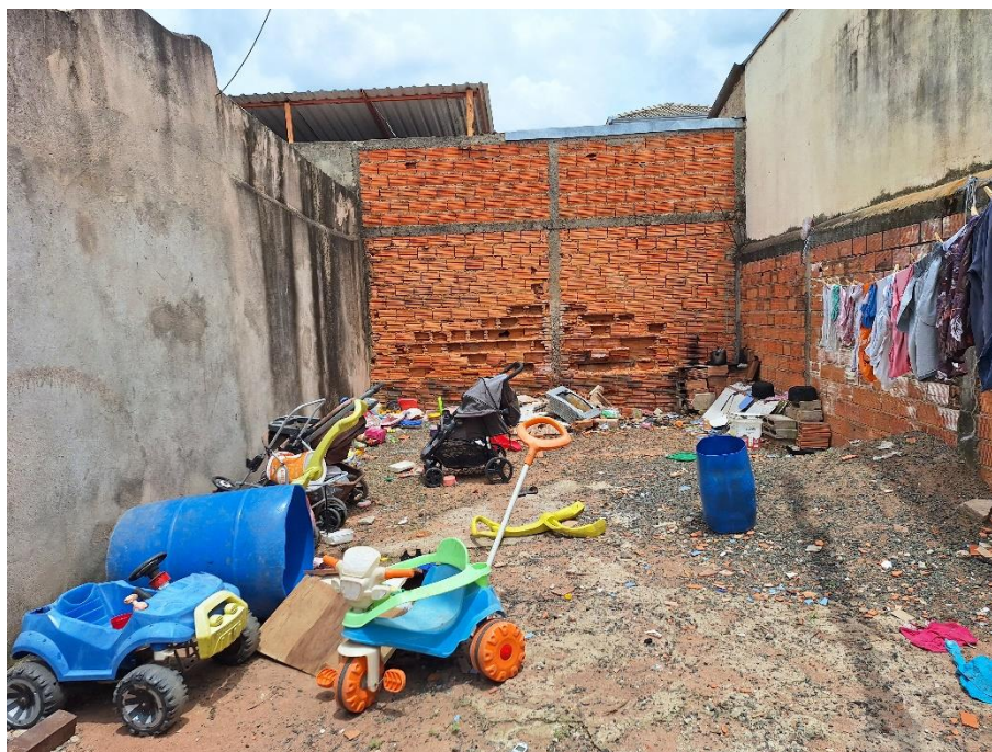
Imagem 95 – Vista Interna – RESIDÊNCIA – QUINTAL / LAVANDERIA / ÁREA DE SERVIÇO. Imóvel verificado durante a DILIGÊNCIA / VISTORIA, pela PERÍCIA DO JUÍZO no local apontado nos autos. Estrutura em alvenaria / reboco. Piso cimentado. Acesso franqueado pela EXECUTADA.
