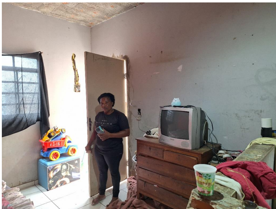
Imagem 77 – Vista Interna – RESIDÊNCIA – Vista para QUARTO / SALA DE ESTAR. Imóvel verificado durante a DILIGÊNCIA / VISTORIA, pela PERÍCIA DO JUÍZO no local apontado nos autos. Estrutura em alvenaria / reboco / pintura. Piso cerâmico. Esquadria de ferro.
