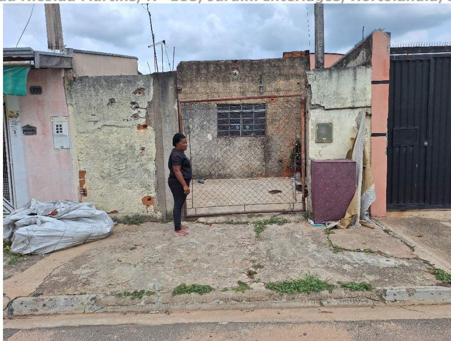
Imagem 68 – Vista Externa – FACHADA PRINCIPAL – RESIDÊNCIA. Imóvel verificado durante a DILIGÊNCIA / VISTORIA, pela PERÍCIA DO JUÍZO no local apontado nos autos. Muro em alvenaria / reboco / pintura. Portão de ferro. Acesso franqueado pela EXECUTADA.
