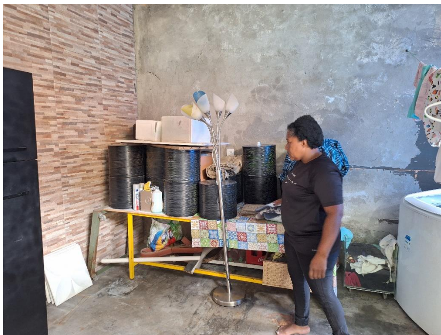
Imagem 58 – Vista Interna – LAVANDERIA / ÁREA DE SERVIÇO. Imóvel verificado durante a DILIGÊNCIA / VISTORIA, pela PERÍCIA DO JUÍZO no local apontado nos autos. Estrutura em alvenaria / reboco. Piso cimentado. Revestimento cerâmico. Acesso franqueado pela EXECUTADA.
