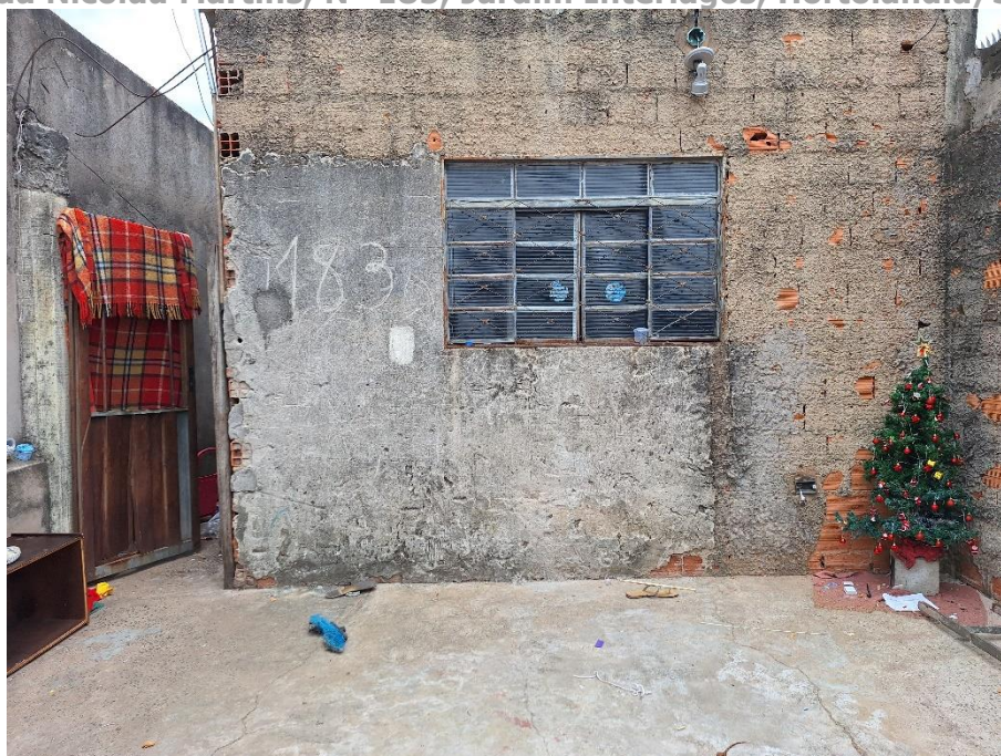
Imagem 70 – Vista Interna – RESIDÊNCIA – GARAGEM / QUINTAL. Imóvel verificado durante a DILIGÊNCIA / VISTORIA, pela PERÍCIA DO JUÍZO no local apontado nos autos. Estrutura em alvenaria / reboco. Piso cimentado. Acesso franqueado pela EXECUTADA.
