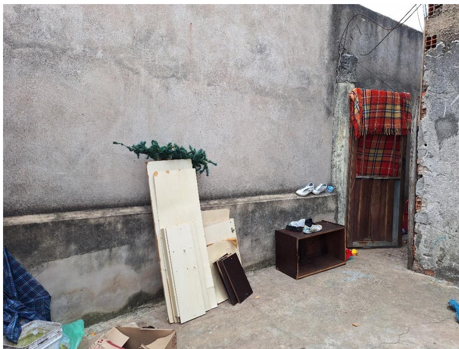
Imagem 71 – Vista Interna – RESIDÊNCIA – GARAGEM / QUINTAL. Imóvel verificado durante a DILIGÊNCIA / VISTORIA, pela PERÍCIA DO JUÍZO no local apontado nos autos. Estrutura em alvenaria / reboco. Piso cimentado. Acesso franqueado pela EXECUTADA.
