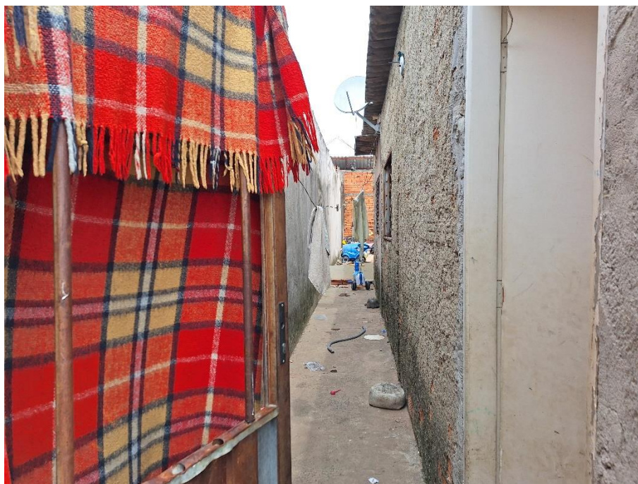
Imagem 73 – Vista Interna – RESIDÊNCIA – CORREDOR DE CIRCULAÇÃO. Imóvel verificado durante a DILIGÊNCIA / VISTORIA, pela PERÍCIA DO JUÍZO no local apontado nos autos. Estrutura em alvenaria / reboco. Piso cimentado. Acesso franqueado pela EXECUTADA.
