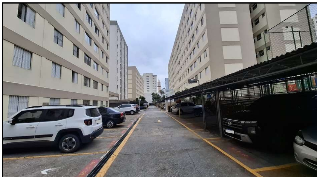
Foto 4: Pavimento Térreo – Estacionamento
