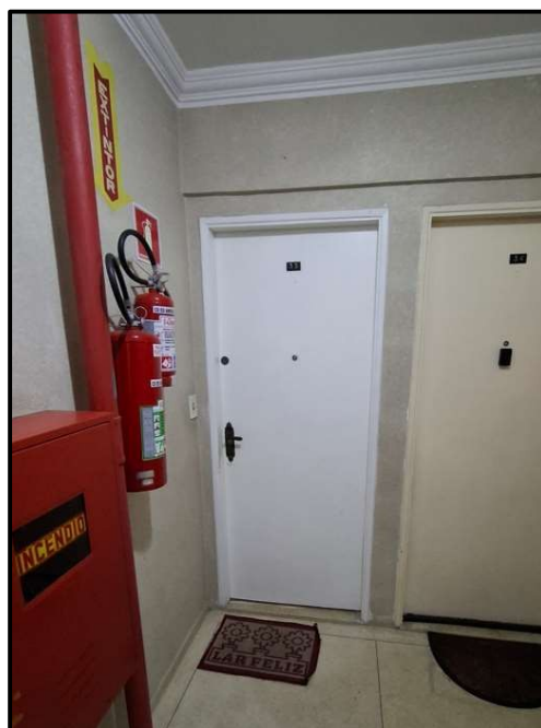
Foto 9: Edifício Guatemala – 3º andar - Porta de entrada do apartamento nº 33-A
