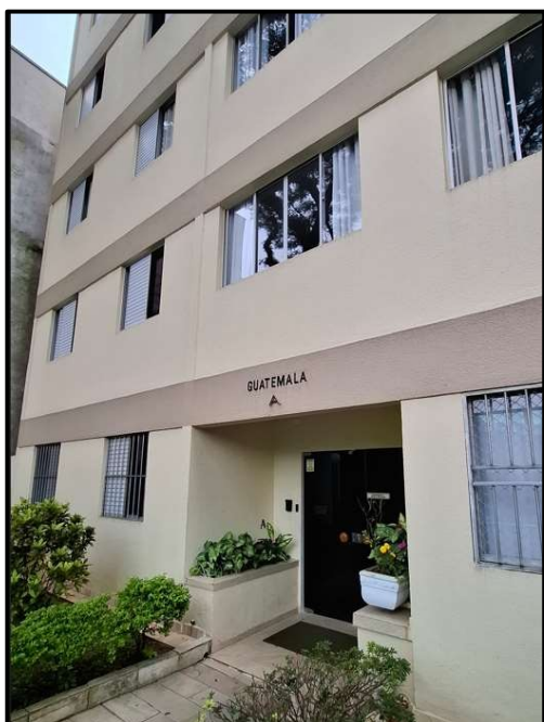
Foto 8: Pavimento Térreo - Edifício Guatemala
