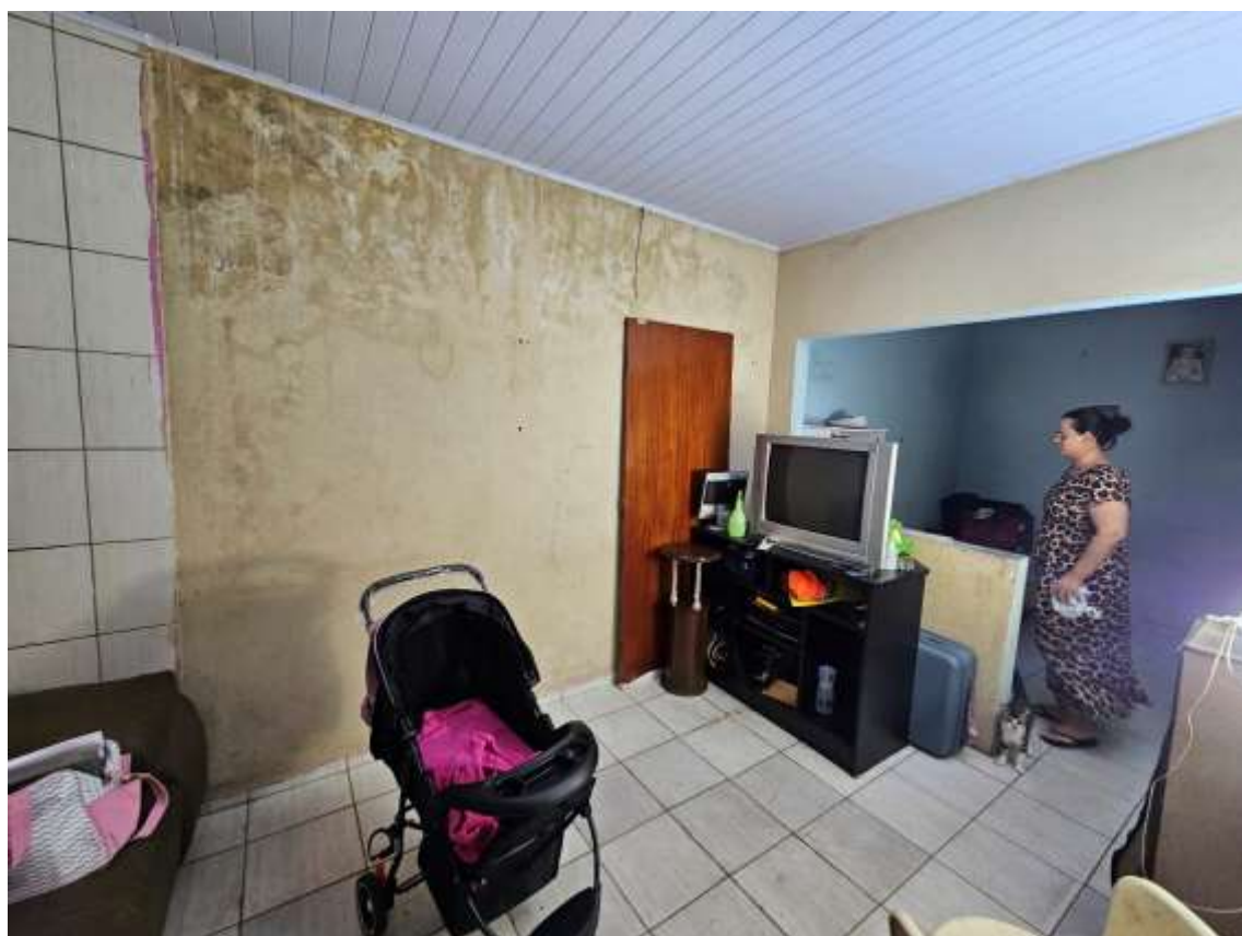
22 – Pavimento Térreo – Casa nº 02 – Sala
