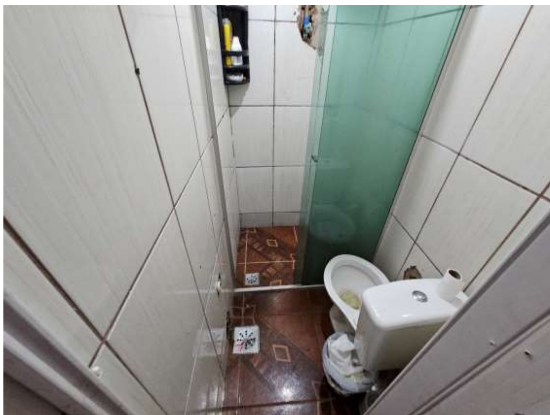
18 – Pavimento Térreo – Casa nº 01 – Banheiro
