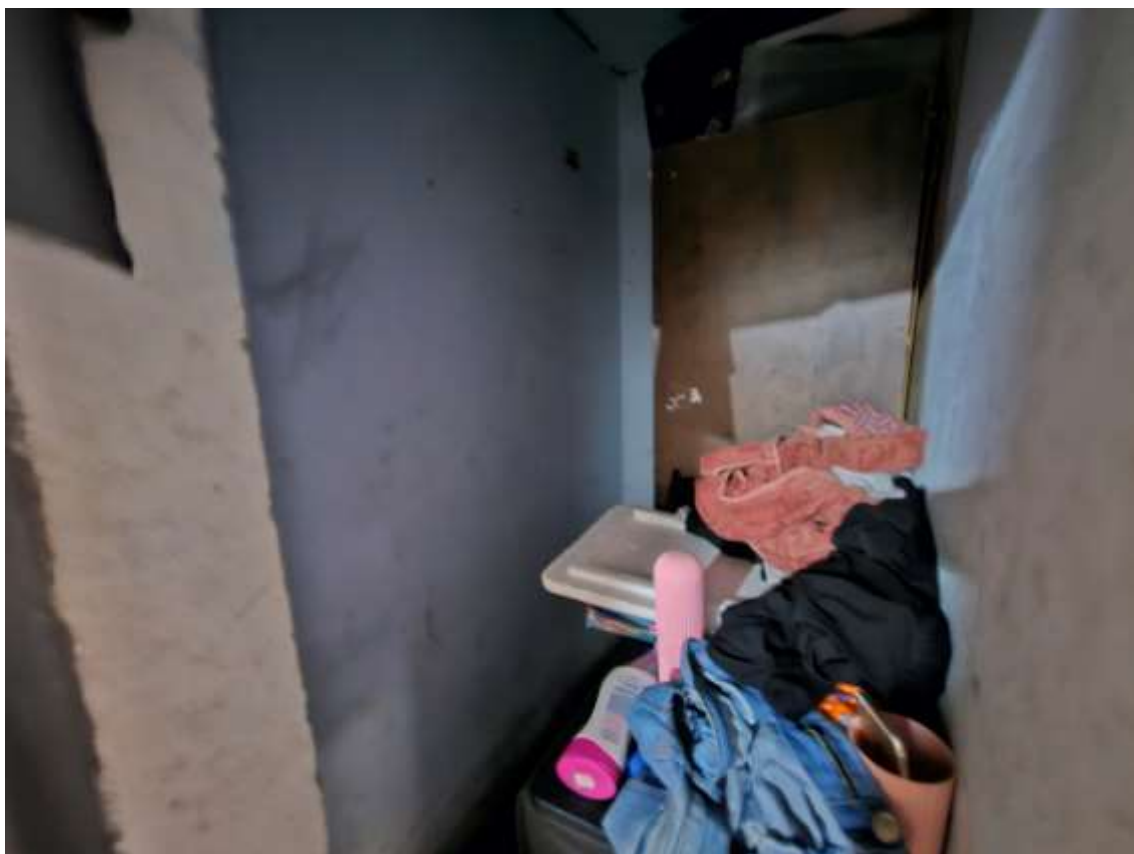
19 – Pavimento Térreo – Casa nº 01 – Depósito
