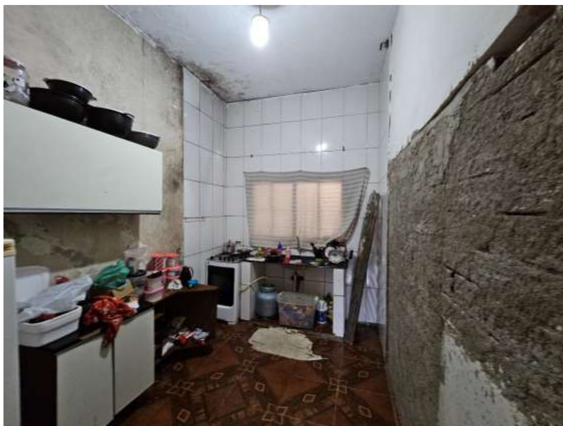
17 – Pavimento Térreo – Casa nº 01 – Cozinha
