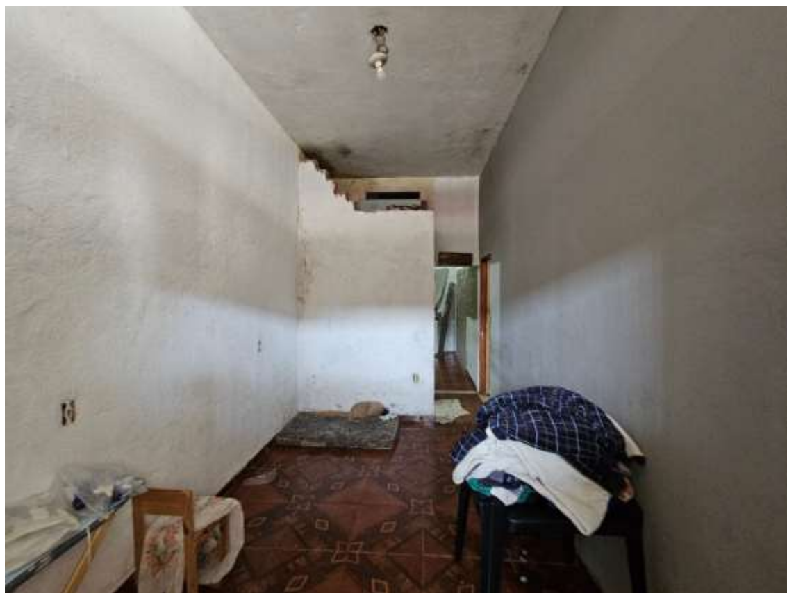
16 – Pavimento Térreo – Casa nº 01 – Sala
