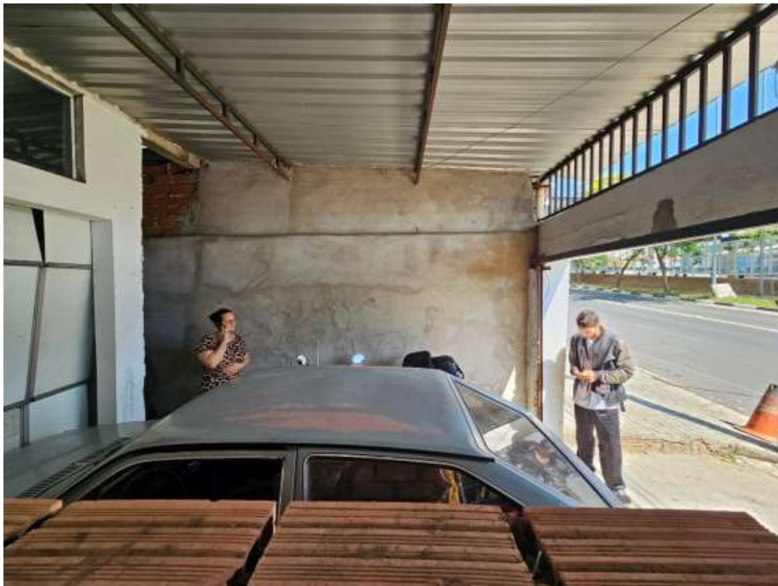
12 – Pavimento Térreo – Garagem (utilizada pelo locatário da casa nº 01)
