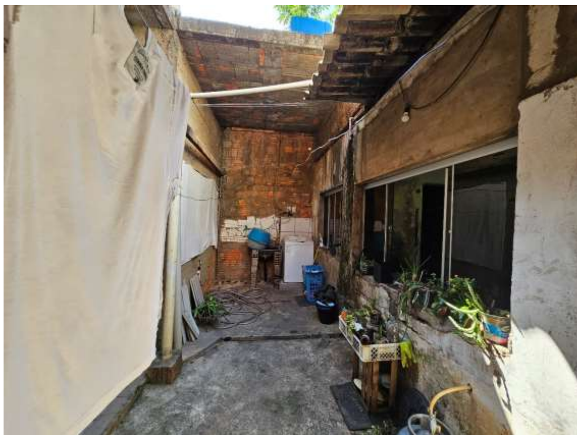
27 – Pavimento Térreo – Casa nº 02 – Área de Serviço
