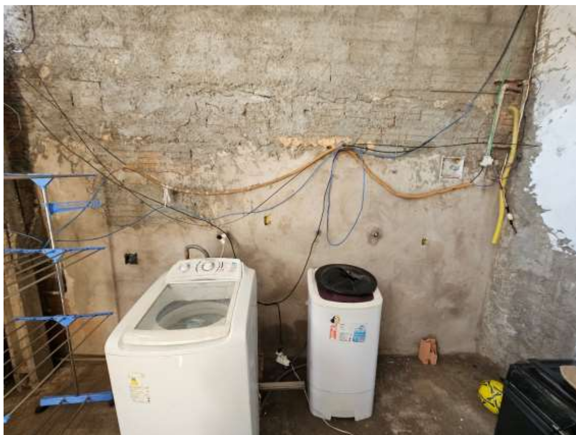
15 – Pavimento Térreo – Casa nº 01 – Área de Serviço
