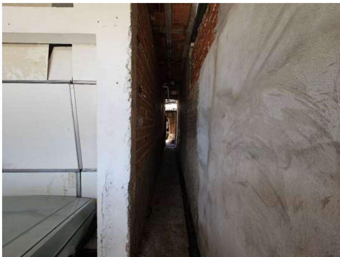
13 – Pavimento Térreo – Corredor de Circulação da garagem para a casa nº 02
