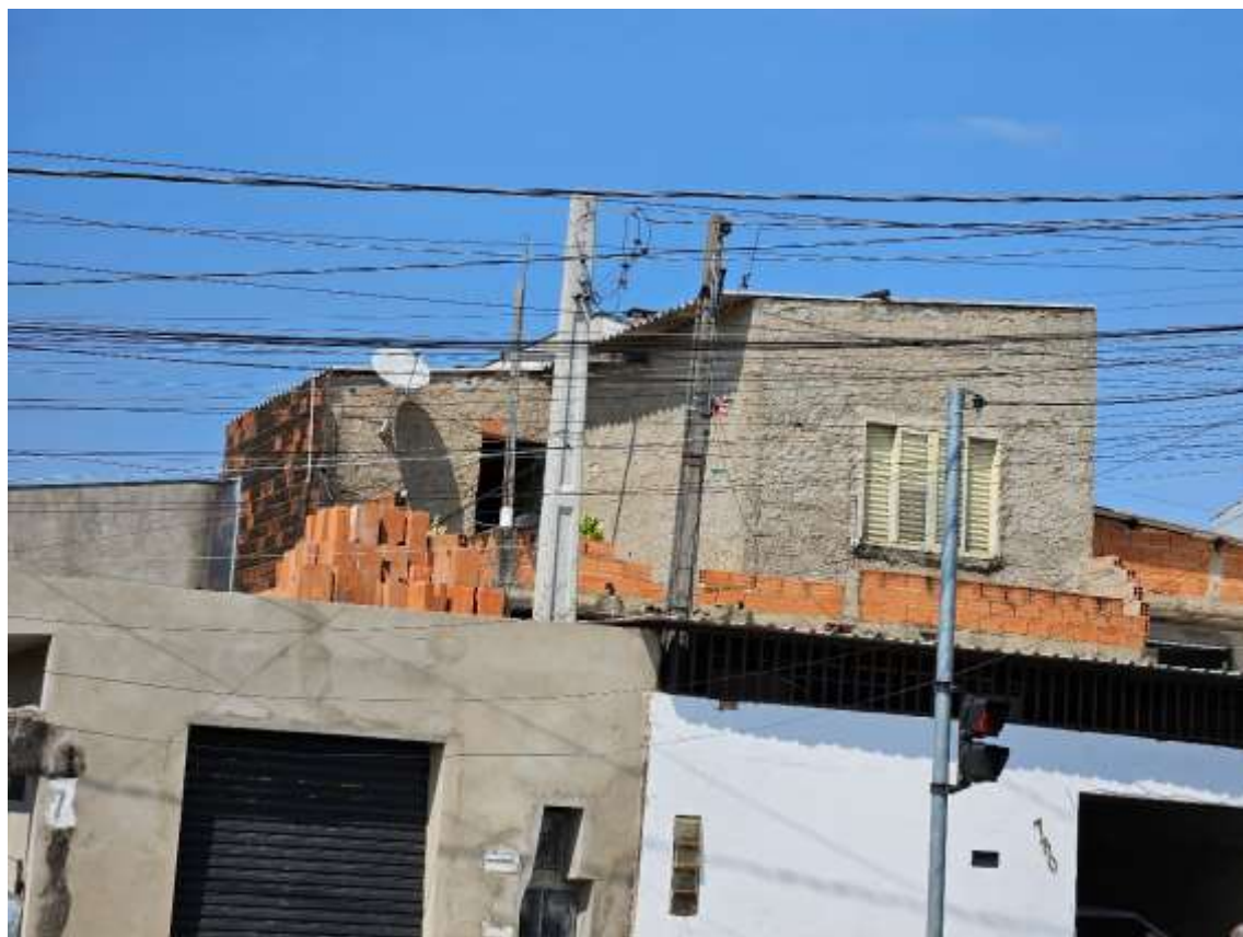
30 – Pavimento Superior – Casa nº 03 – Vista geral externa (não foi facultado o acesso)
