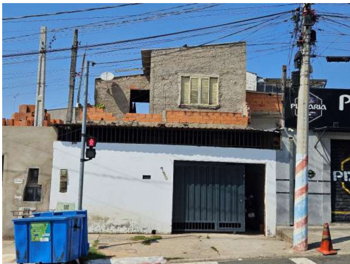
02 – Vista Frontal do Imóvel
