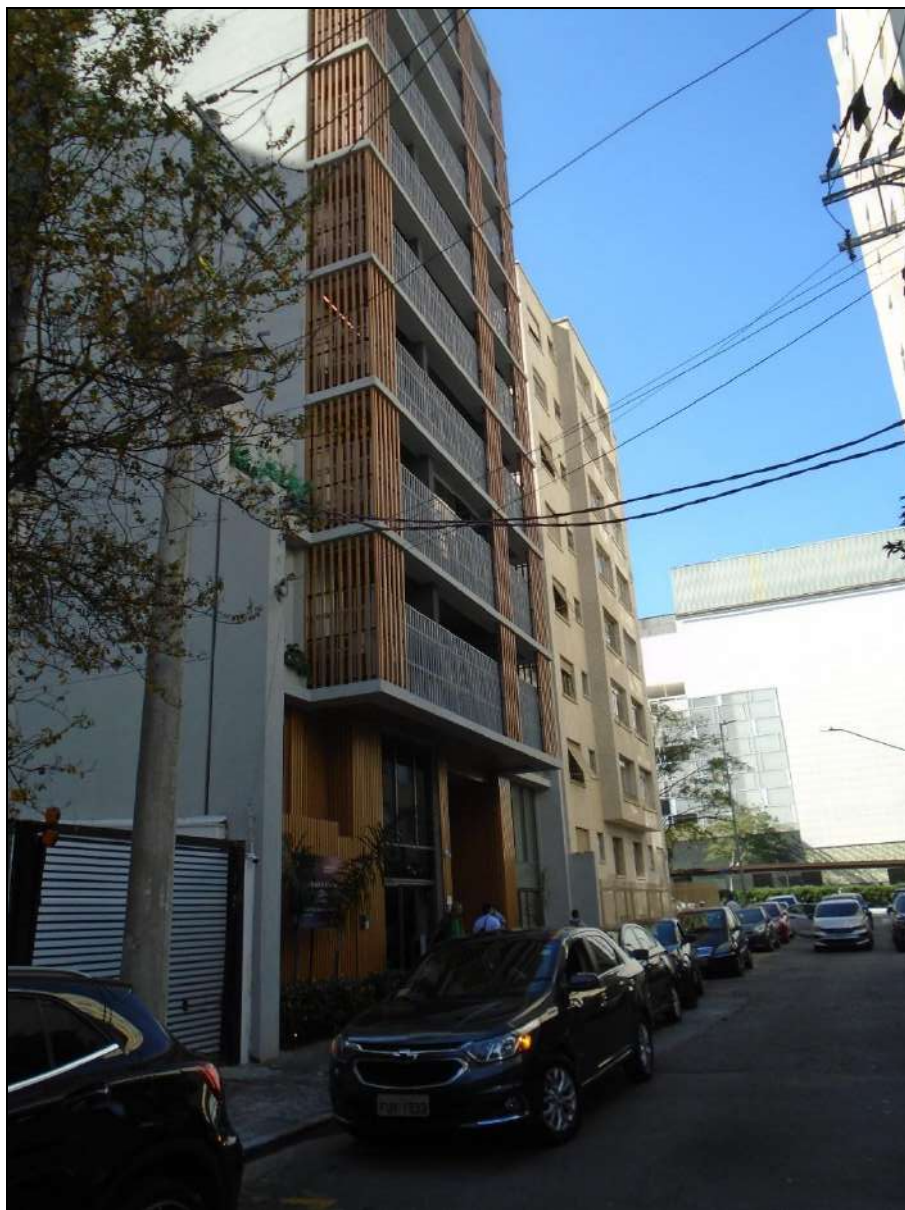
FOTO 04- NOVO EMPREENDIMENTO VIZINHO AO ED. MIAMI AVENUE.
