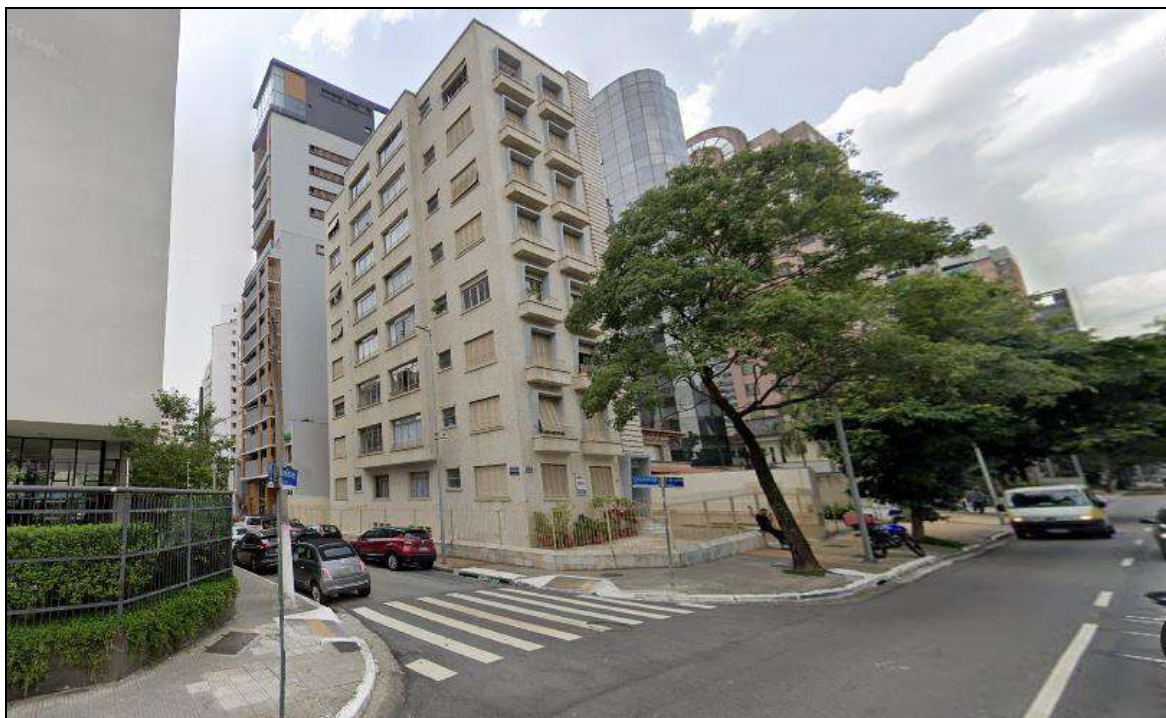
FOTO 02 - PRÉDIOS DÉCADA DE 70 E NOVOS EMPREENDIMENTOS.
