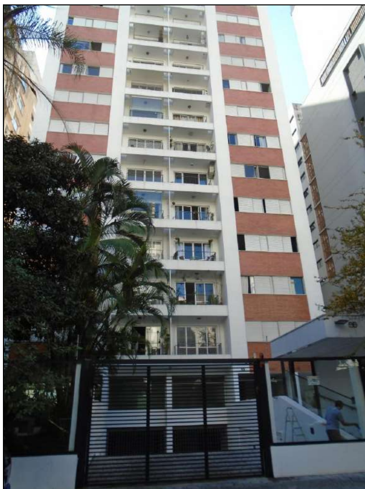
FOTO 05 - FACHADA DO PRÉDIO.
