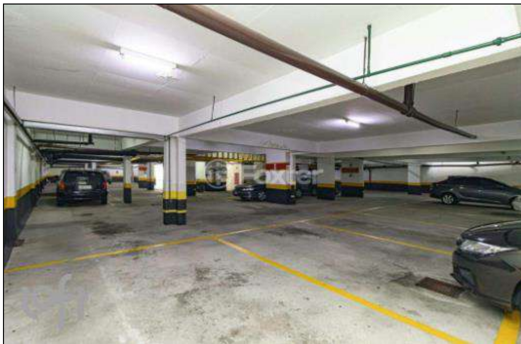
FOTO 09 - RAMPA ACESSO PARA ENTRADA E SAÍDA.
