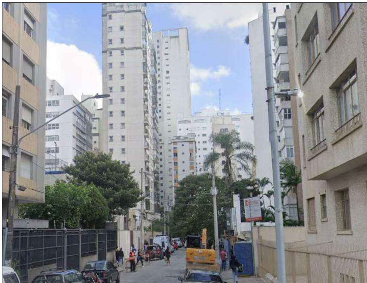
FOTO 03- ASPECTO GERAL DA OCUPAÇÃO JUNTO AO PRÉDIO.
