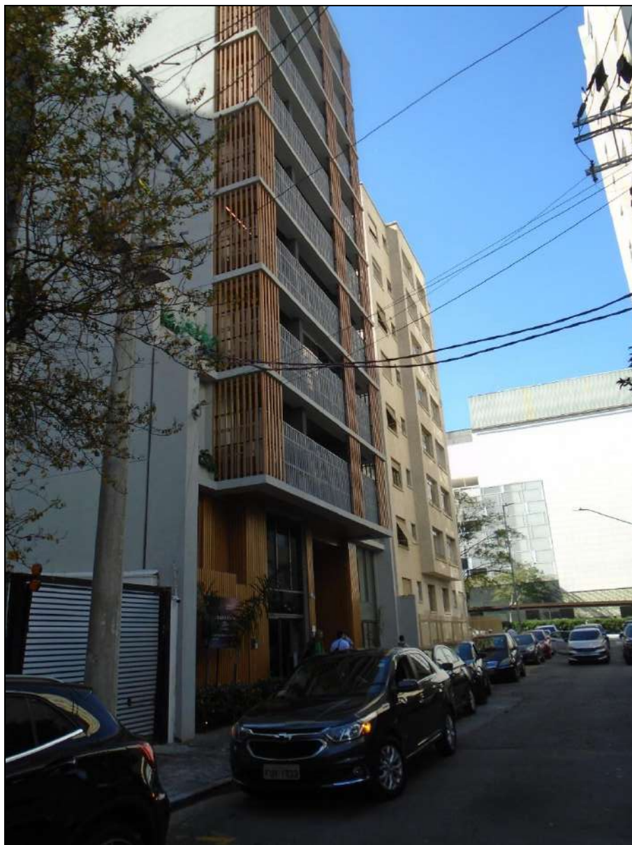
FOTO 04- NOVO EMPREENDIMENTO VIZINHO AO ED. MIAMI AVENUE.
