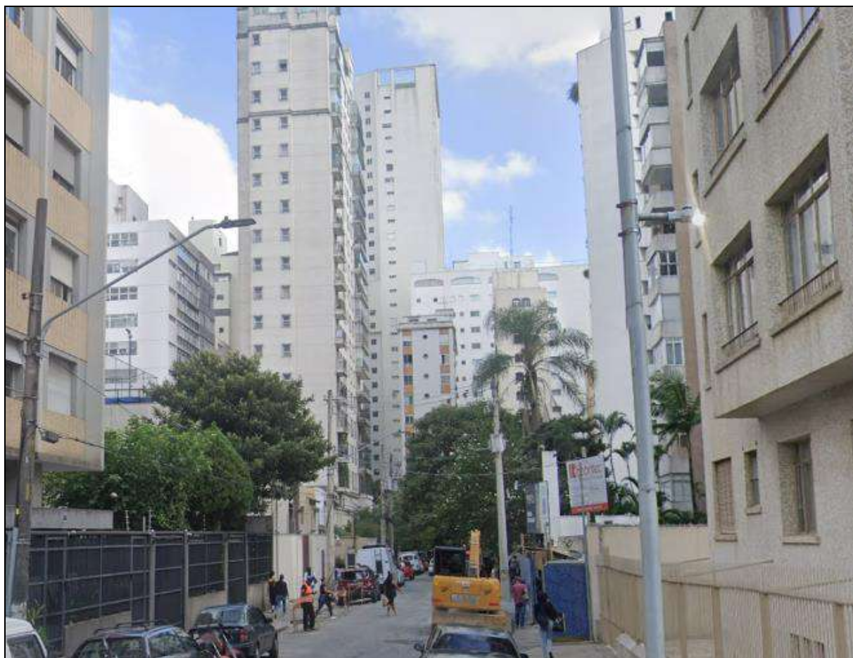
FOTO 03- ASPECTO GERAL DA OCUPAÇÃO JUNTO AO PRÉDIO.
