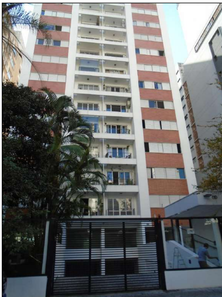
FOTO 05 - FACHADA DO PRÉDIO.
