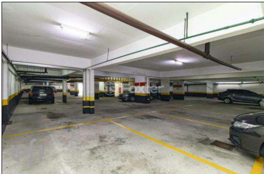
FOTO 09 - RAMPA ACESSO PARA ENTRADA E SAÍDA.
