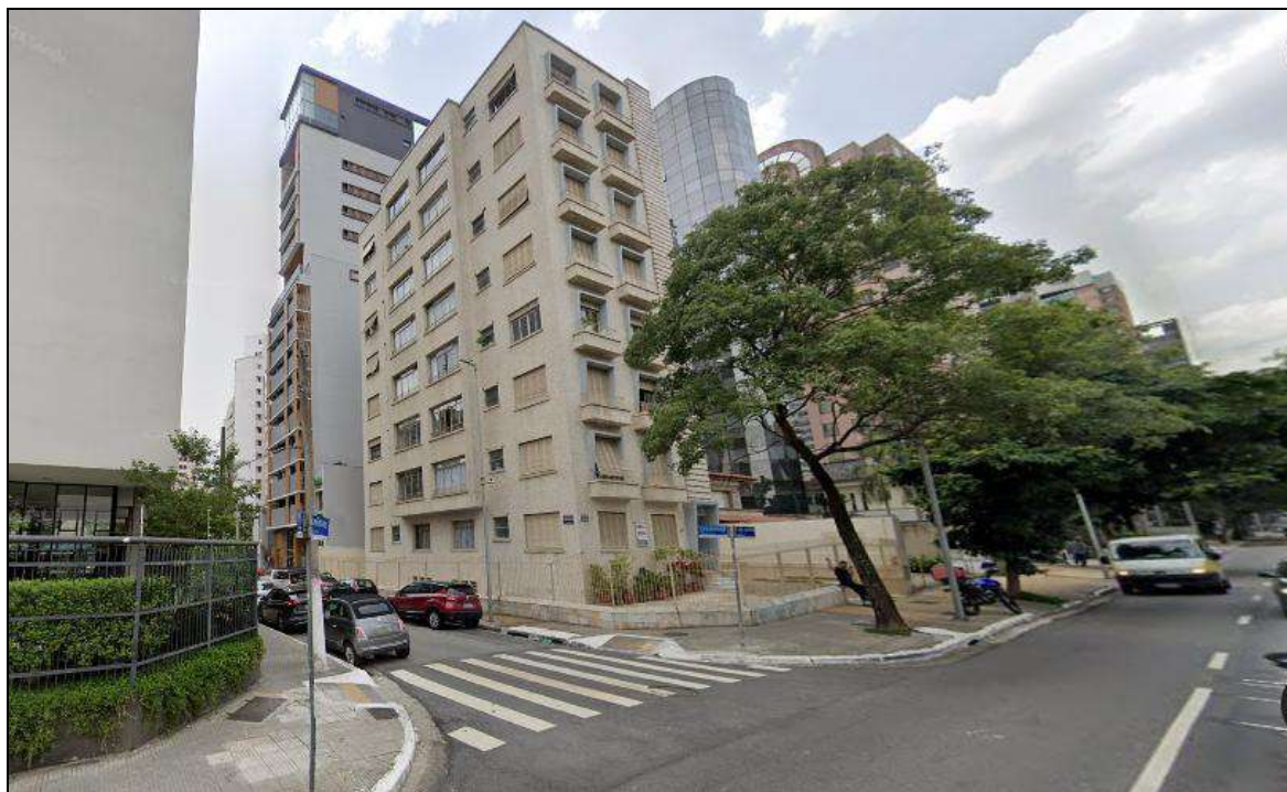
FOTO 02 - PRÉDIOS DÉCADA DE 70 E NOVOS EMPREENDIMENTOS.
